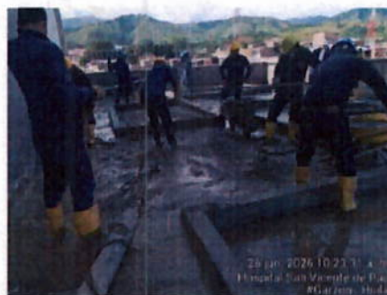
Pendientado terraza tercer piso.
