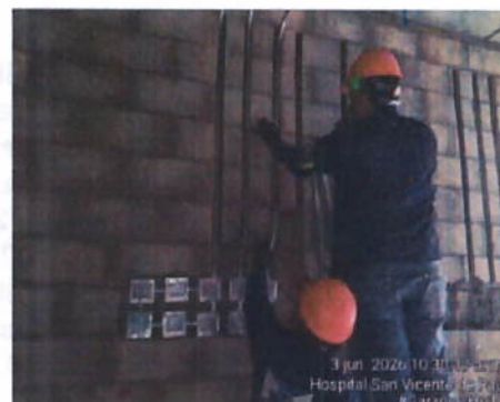
Salidas para cabeceros primer piso.
