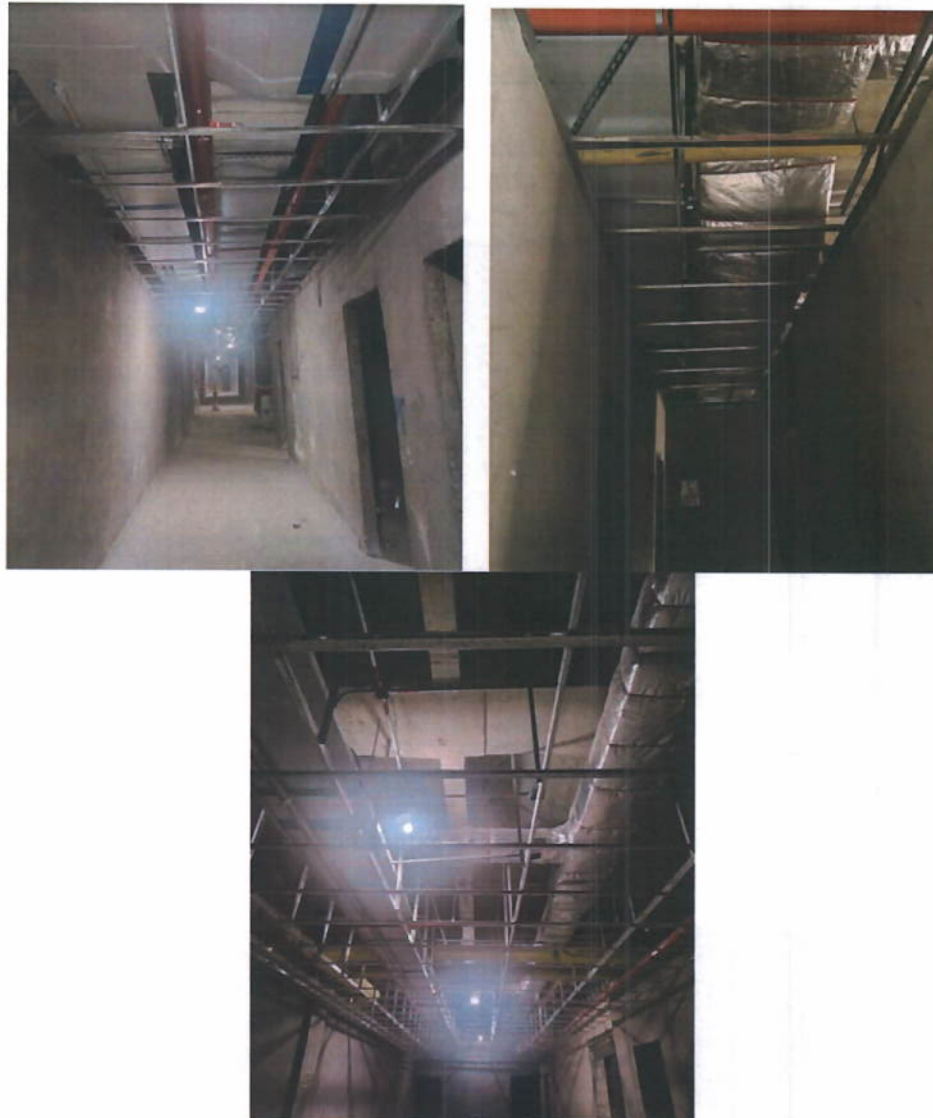
Ilustración 26. Instalación de estructura de Cielo Raso
