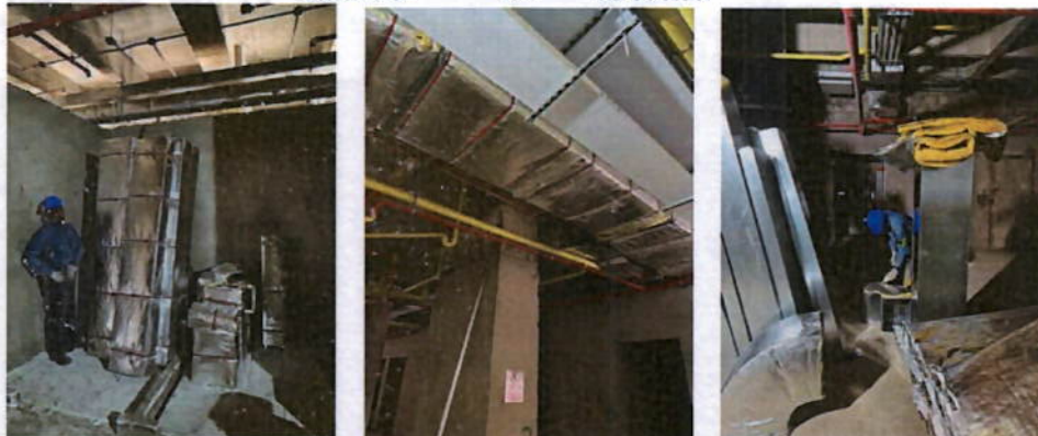
Ilustración 13. Instalación de aislamiento para ductos.
