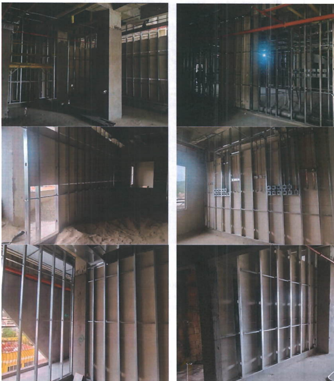
Ilustración 21. Estructura y tapa (1 cara) muros livianos
