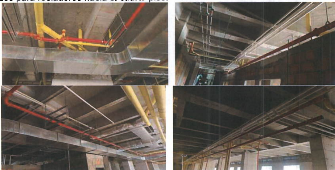
Ilustración 14. Instalación de tubería Red Contra Incendios
