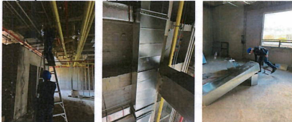
Ilustración 12. Instalación de ductos.
