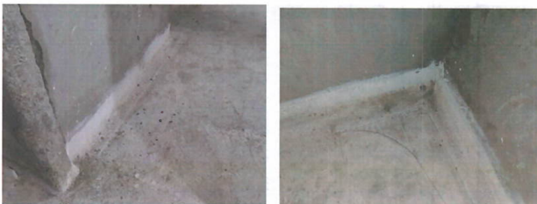
Ilustración 28. Instalación de guardaescobas en mediacaña.
