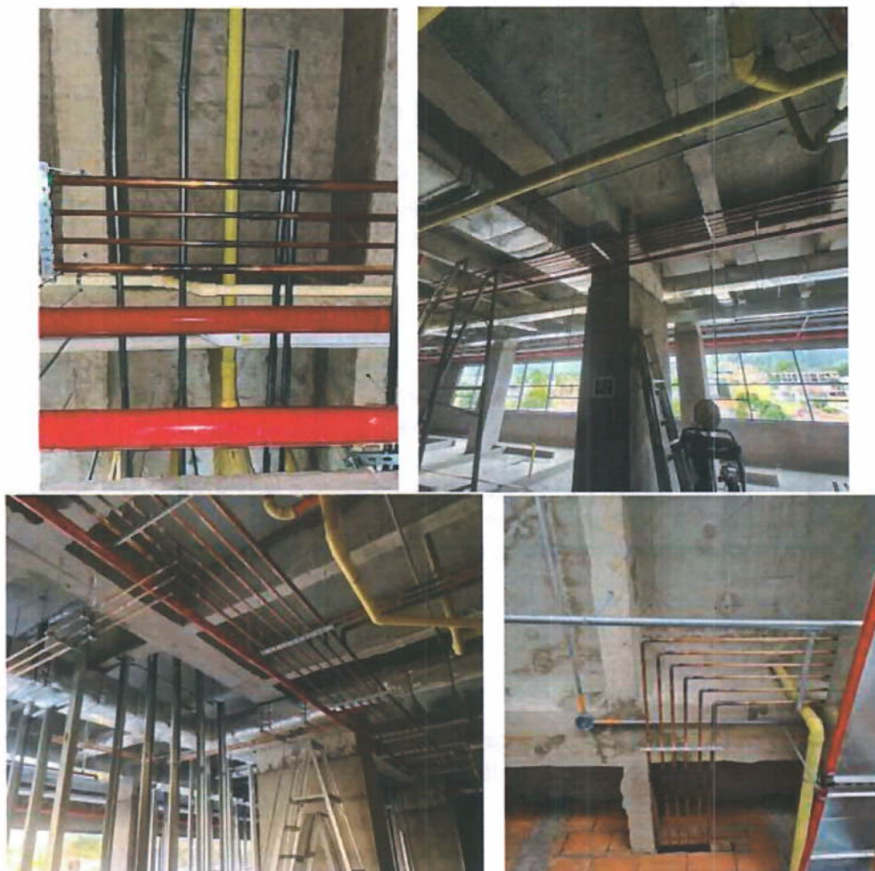
Ilustración 15. Instalación de sistema de gases medicinales
