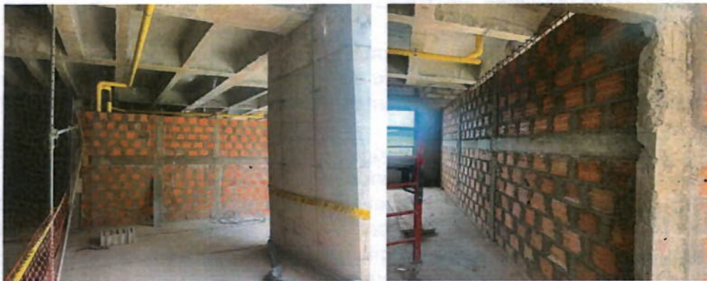
Ilustración 4. Armado de mampostería
