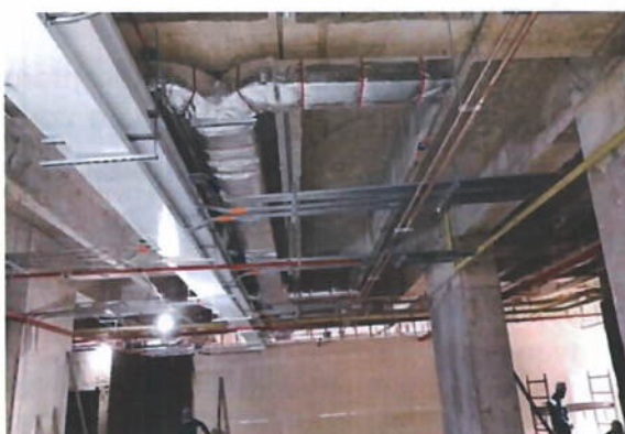
Ilustración 9. Instalación de bandejas portacables.
