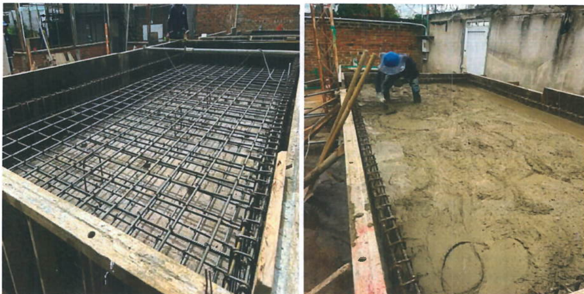
Ilustración 3. Construcción de placas para los equipos chillers
