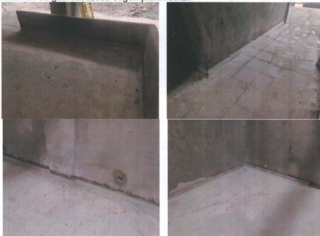
Ilustración 29. Instalación de guardaescobas tipo zócalo.
