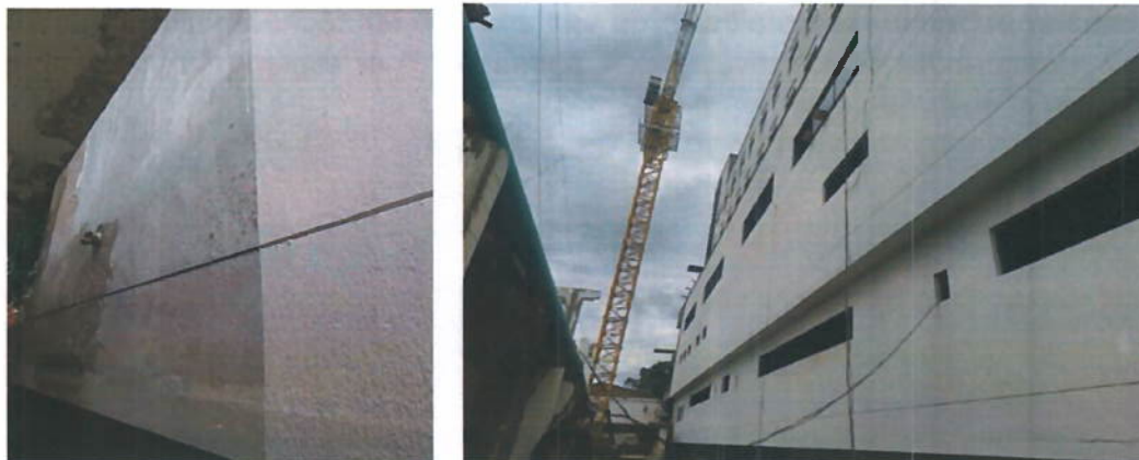
Ilustración 31. Aplicación de Graniplast como acabado sobre fachada.
