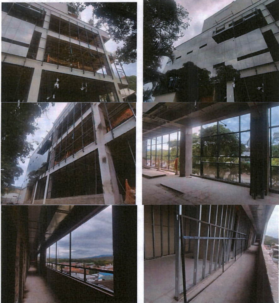
Ilustración 30. Instalación de ventanas en fachada.
