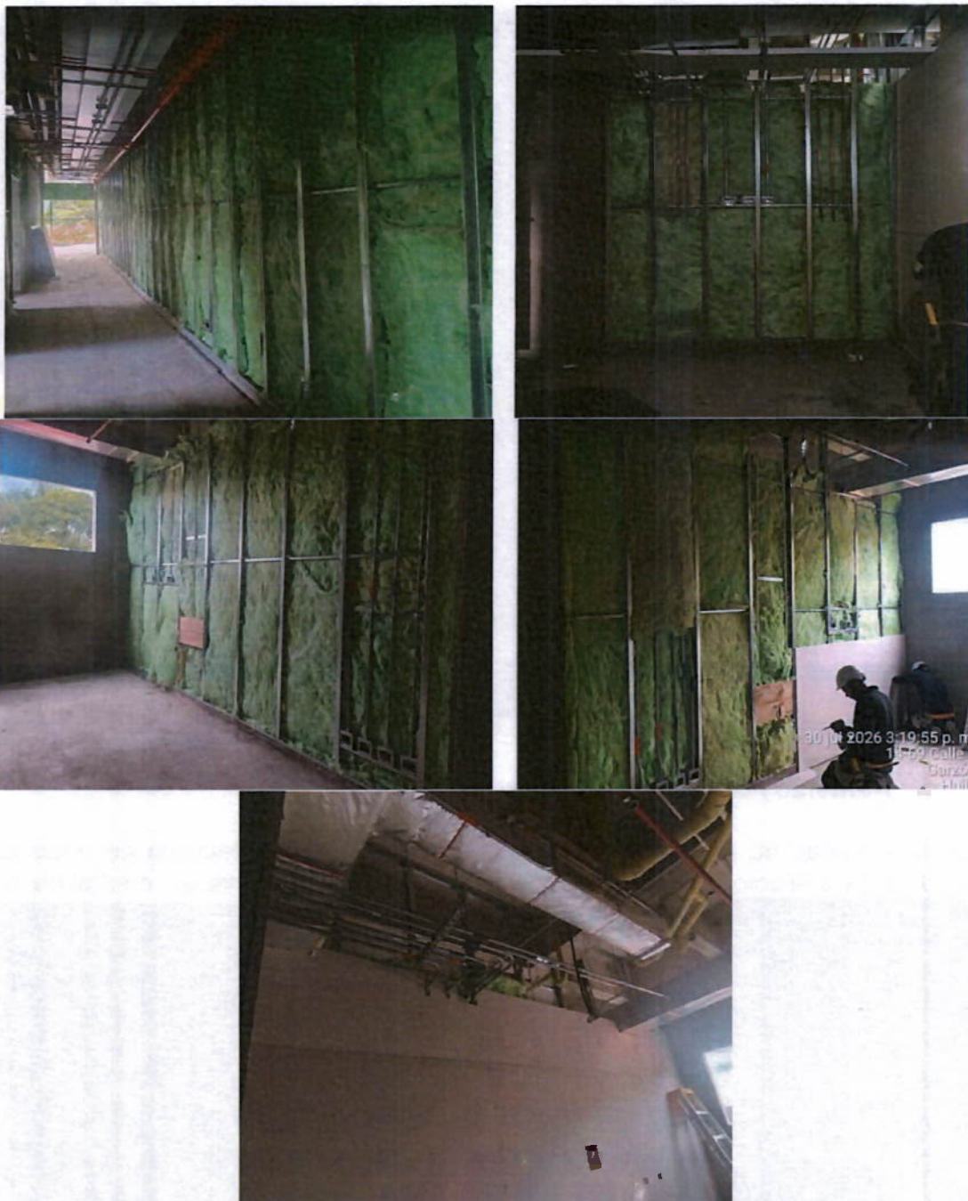
Ilustración 22. Instalación de fresca como relleno en estructura de Muros Livianos
