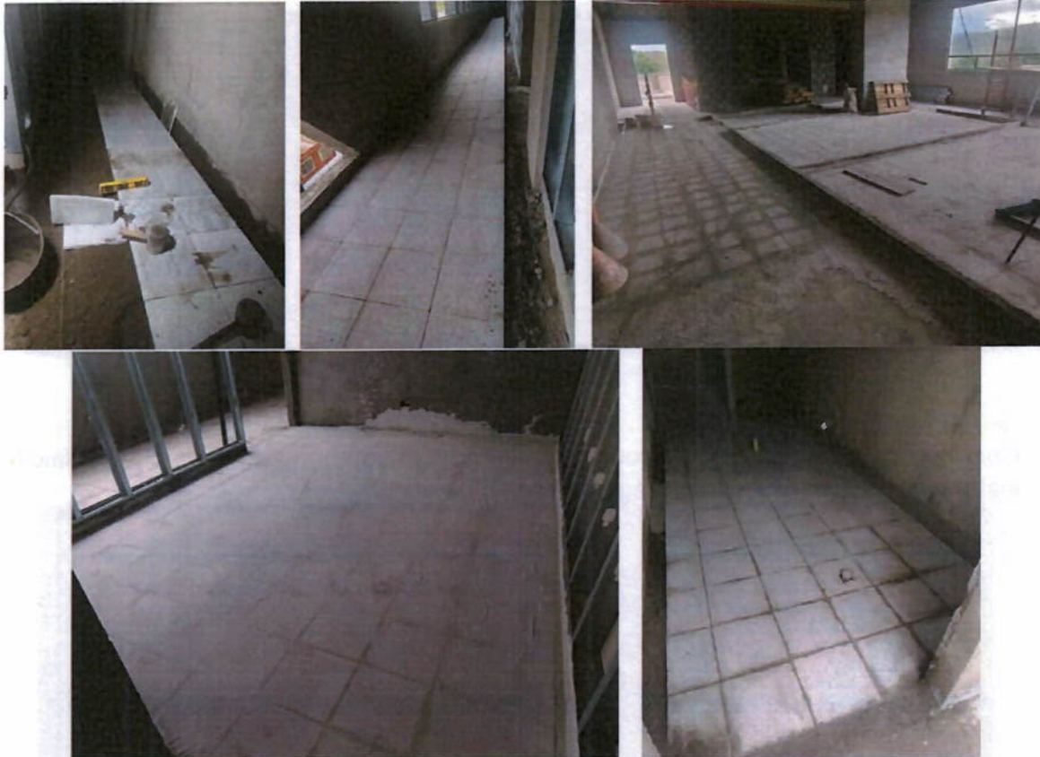
Ilustración 27. Instalación de piso en tableta vibropresada.
