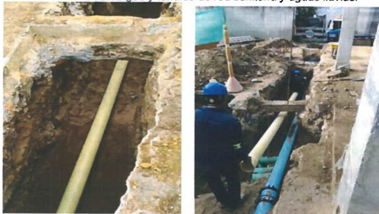
Ilustración 11. Tendido de red sanitaria patógenas predio B.
