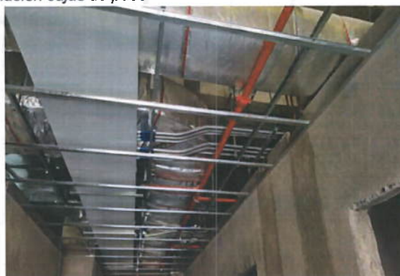
Ilustración 8. Instalación de tomas y cajas de derivación.
