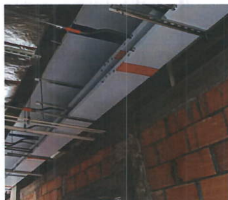
Ilustración 9. Instalación de bandejas portacables.
