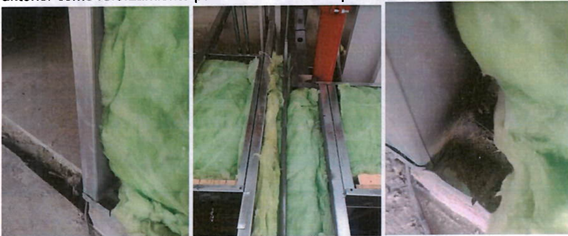
Ilustración 25. Refuerzo vertical metálico para muros livianos.
