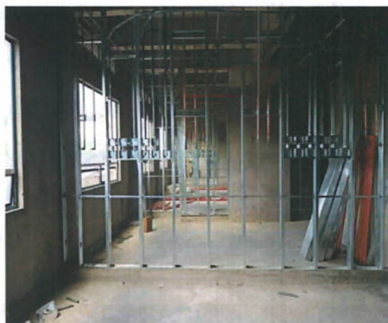
Ilustración 7. Instalación cajas de paso
