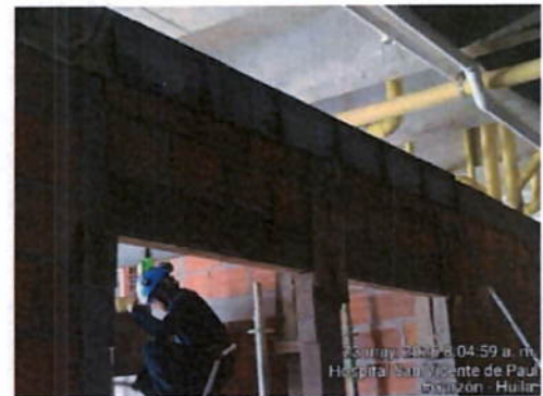
Intervención elementos de confinamiento en cuarto piso
