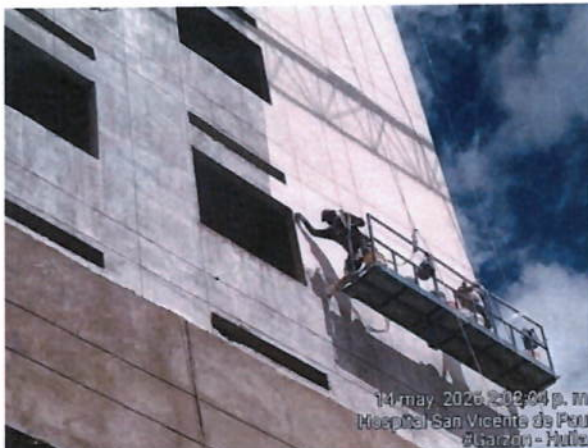
Fachada costado Oeste sobre hospital
