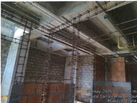
Intervención elementos de confinamiento en cuarto piso
