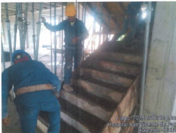
Escalera de emergencia eje 8-9 entre C y D de segundo a tercer piso
