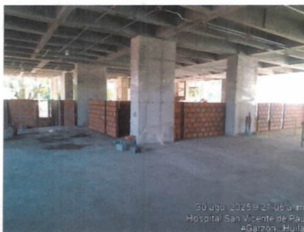
Mampostería en proceso en primer piso edificio asistencial.
