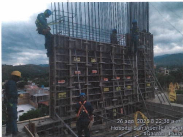
Intervención muro cortina eje 2 entre C y D quinto piso.
