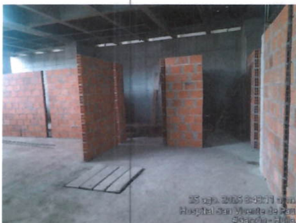
Mampostería primer piso área de comunicaciones y residuos en sótano.
