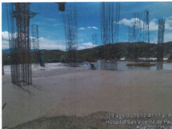
Proceso de fundida del último tramo de la placa aligerada de tercer piso.
