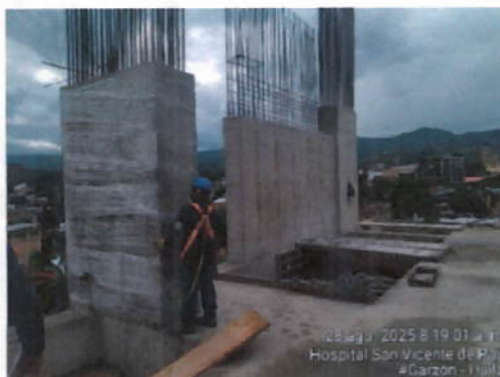
Intervención muro cortina eje 2 entre C y D quinto piso.
