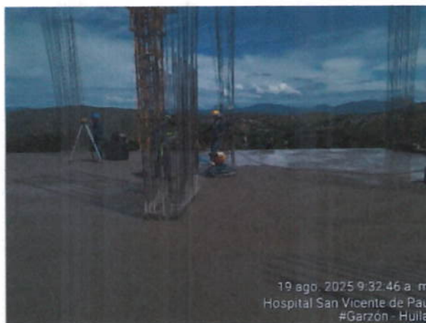
Proceso de fundida del último tramo de la placa aligerada de tercer piso.
