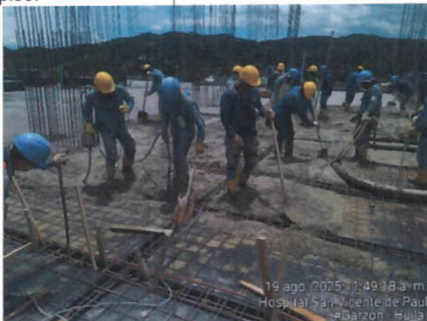
Proceso de fundida del último tramo de la placa aligerada de tercer piso.
