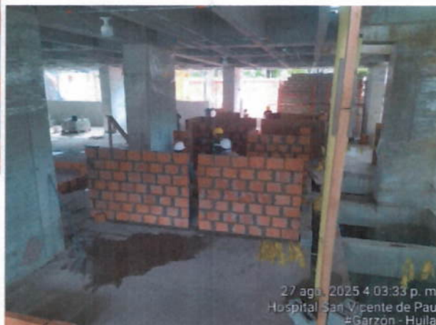
Mampostería en proceso en primer piso edificio asistencial.
