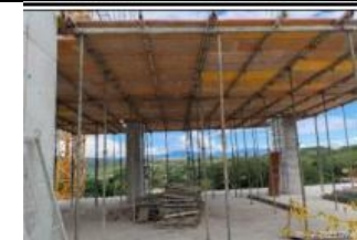
ARMADO Y TENDIDO DE ESTRUCTURA PARA PLACA AEREA DE 5 PISO ENTRE LOS EJES 2-5 AL C-F
