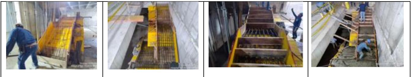
ARMADO DE ACERO DE REFUERZO, ENCOFRADO Y FUNDIDA DE ESCALERAS DE EMERGENCIA
