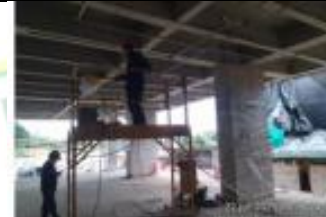
INSTALACION DE TUBERIA ELECTRICA EMT Y ACCESORIOS A NIVEL DEL 1 PISO ENTRE LOS EJES 5-9 Y C-F
