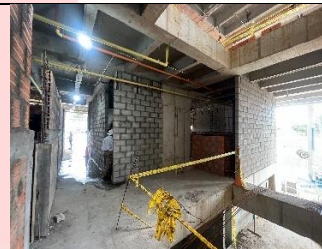
MURO DE BLOQUE DE CONCRETO SOBRE FACHADAS
