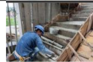
FUNDICION DE ESCALERA DE EMERGENCIA DEL 1 AL 2 PISO
