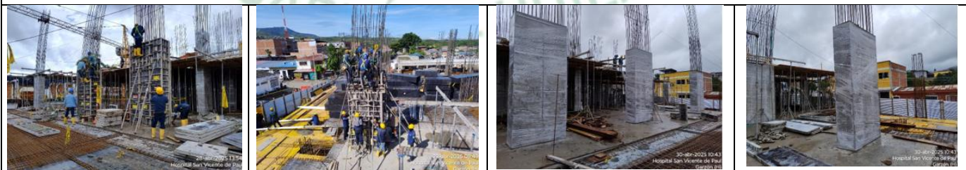
CONSTRUCCION DE 4 COLUMNAS 1 NIVEL (A6 - B7 - C7 - D7)
