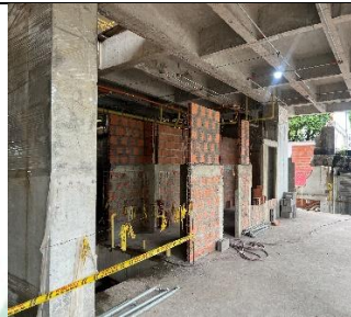
ALZADO DE MUROS EN BLOQUE DE ARCILLA EN ZONAS HÚMEDAS
