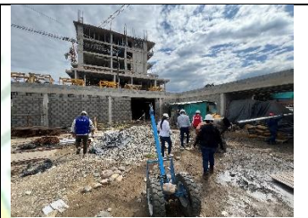
ALZADO DE MUROS EN BLOQUE DE ARCILLA EN ZONAS HÚMEDAS
