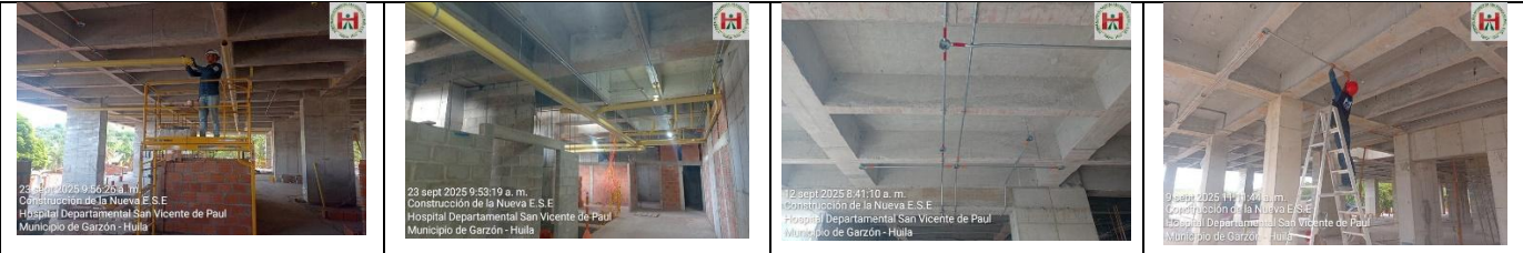
INSTALACIÓN DE TUBERÍA SANITARIA
