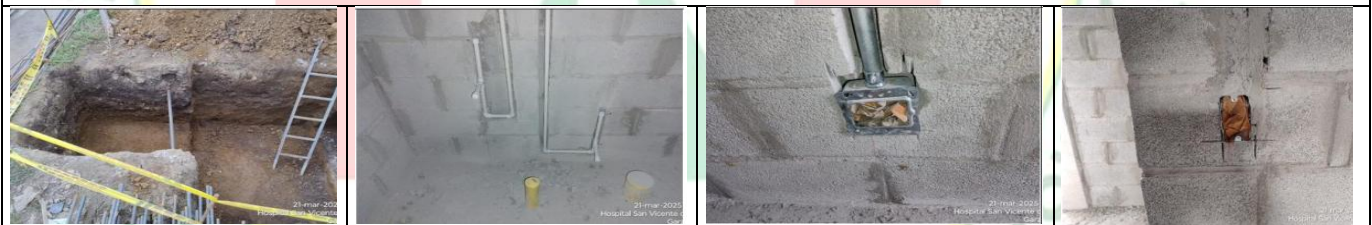
EXCAVACION PARA CAJA ELECTRICA
