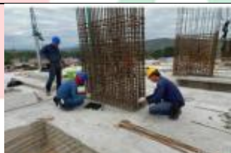
ARMADO DE ACERO DE REFUERZO COLUMNAS NIVEL DE 3 PISO ENTRE LOS EJES B - F
