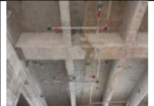
INSTALACION DE TUBERIA ELECTRICA EMT Y ACCESORIOS A NIVEL DEL 1 PISO ENTRE LOS EJES 5-9 Y C-F
