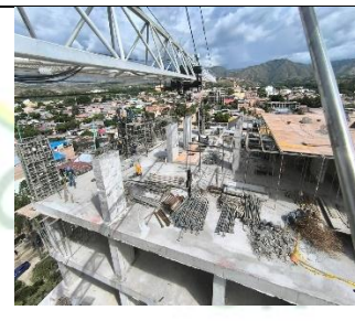
MONTAJE DE PLATAFORMA PARA PLACA DE CUBIERTA ENTRE EJES 2-4, ARMADO DE ACERO Y FUNDIDA DE PLACA AÉREA DE CUBIERTA ENTRE EJES 2 - 9 Y B - F.
