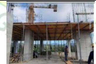
ARMADO Y TENDIDO DE ESTRUCTURA PARA PLACA AEREA DE 5 PISO ENTRE LOS EJES 2-5 AL C-F
