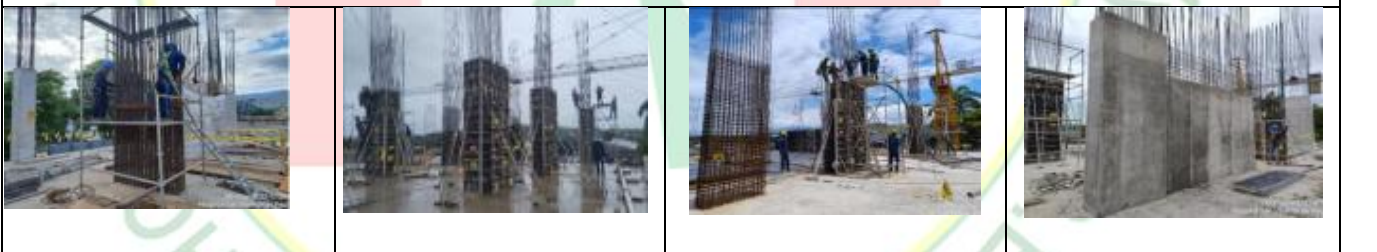
ARMADO DE ACERO DE REFUERZO, ENCOFRADO Y VACIADO DE COLUMNAS 2 PISO
