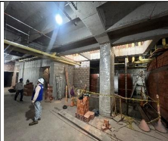
ALZADO DE MUROS EN BLOQUE DE ARCILLA EN ZONAS HÚMEDAS
