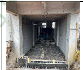
EXCAVACIÓN Y RELLENO PARA ARMADO DE RAMPA VEHICULAR, ACCESO AL SÓTANO POR CALLE SEXTA Y - FUNDIDA DE RAMPA VEHICULAR ACCESO AL SÓTANO POR CALLE SEXTA.
