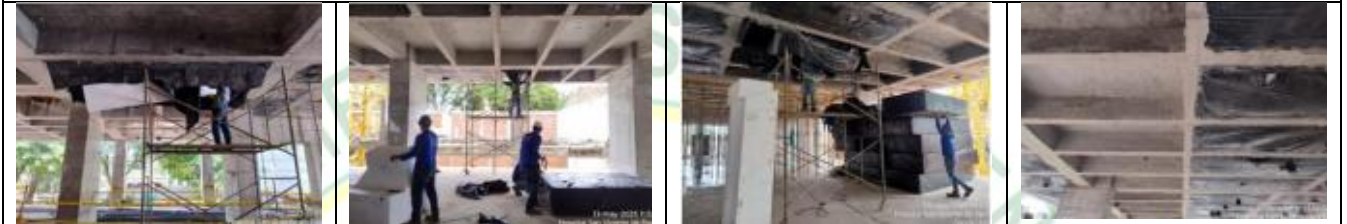
RETIRO Y LIMPIEZA DE CASETONES DEL PRIMER PISO
