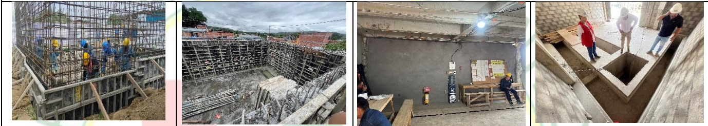
ARMADO DE ACERO PARA TANQUE RCI EN LOTE B DEL EDIFICIO 3, SE REALIZO EL PAÑETE INTERIOR Y EXTERIOR EN LOTE B EDIFICIO 1 EN ÁREA DE SUBESTACIÓN ELÉCTRICA, FUNDIDA DE TANQUE RCI EN LOTE B Y SE INICIA TRABAJOS PARA ARMADO DE PLACA AÉREA DEL TANQUE RCI.
