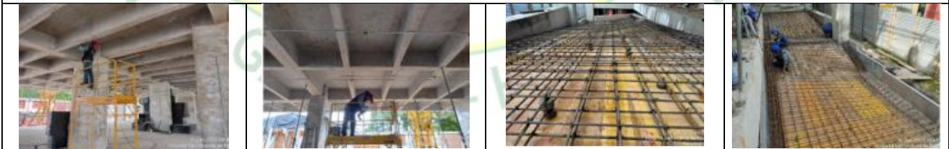
INSTALACION DE TUBERIA ELECTRICA EMT Y ACCESORIOS A NIVEL DEL 1 PISO ENTRE LOS EJES 4 AL 7 Y C-F
