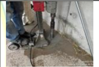
SACA NUCLEOS DE SALIDAS SANITARIAS A NIVEL DEL 1 PISO ENTRE LOS EJES 1-6 AL A-F
