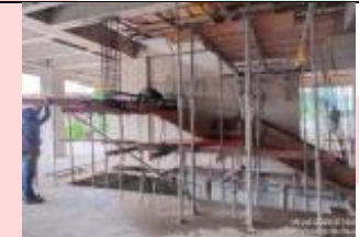
FUNDICION DE ESCALERA DE EMERGENCIA DEL 1 AL 2 PISO
