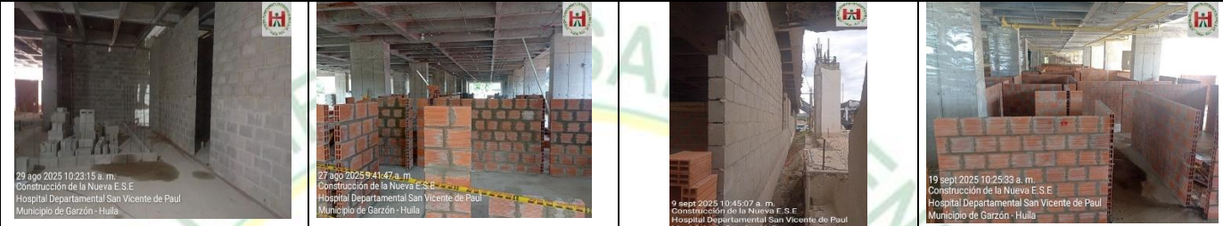
MAMPOSTERÍA EN ARCILLA, DE IGUAL MANERA SE ARMAN Y FUNDEN COLUMNETAS Y VIGAS DE CONFINAMIENTO.
