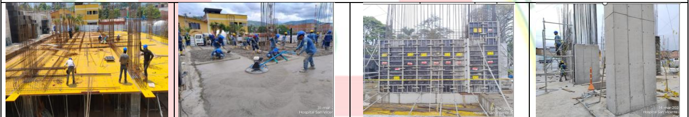
INSTALACION DE FORMALETA PARA LA PLACA DEL 1 PISO ARMADO DE ACEROS DE REFUERZO PARA VIGAS, RÍOSTRAS Y FUNDICION DE LA PLACA.
