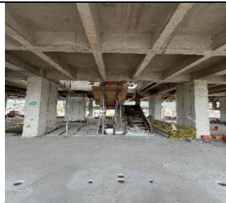
ARMADO DE ESCALERA DE EMERGENCIA
