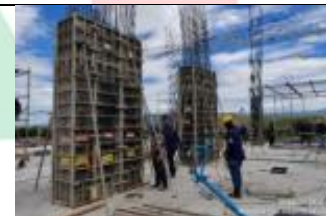
ARMADO DE ACERO DE REFUERZO COLUMNAS NIVEL DE 3 PISO ENTRE LOS EJES B - F
