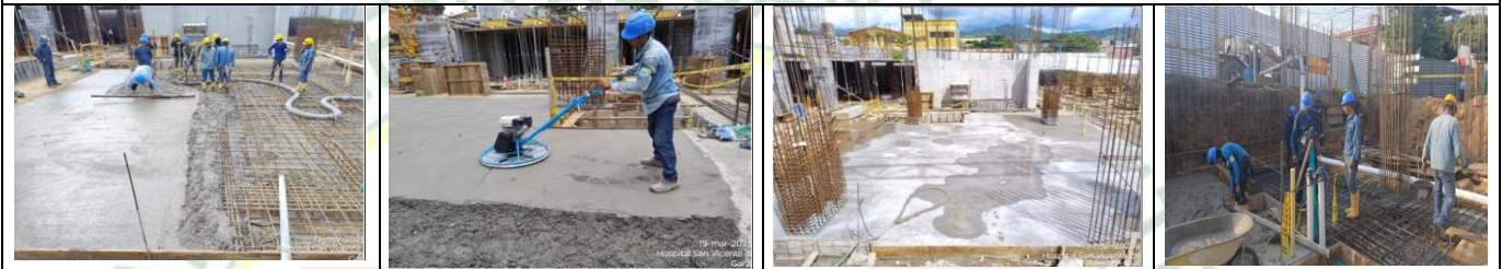
FUNDICION DE VIGAS, RÍOSTRAS Y PLACA DE CONTRAPISO DE LOS EJES 6 AL 9 ENTRE LOS EJES A AL F
