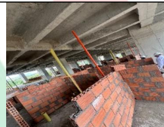
MURO DE BLOQUE DE CONCRETO SOBRE FACHADAS
