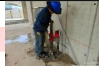
SACA NUCLEOS DE SALIDAS SANITARIAS A NIVEL DEL 1 PISO ENTRE LOS EJES 1-6 AL A-F
