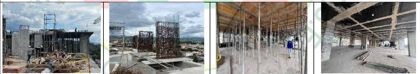
ARMADO DE ACERO PARA COLUMNAS A NIVEL DE SÉPTIMO PISO ENTRE EJES 7 Y 9 ENTRE C-F, CONTINÚA ARMADO DE ACERO Y FUNDIDA DE PLACA AÉREA A NIVEL DE SÉPTIMO PISO ENTRE EJES 2-9, DESMONTE Y RETIRO DE CASOTÓN A NIVEL DE QUINTO PISO.
