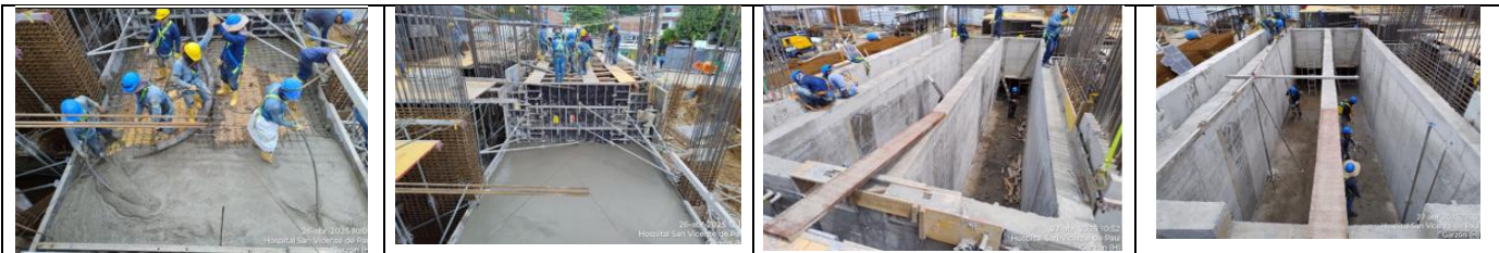
ENCOFRADO Y FUNDIDA DE TANQUE A NIVEL DE SOTANO
