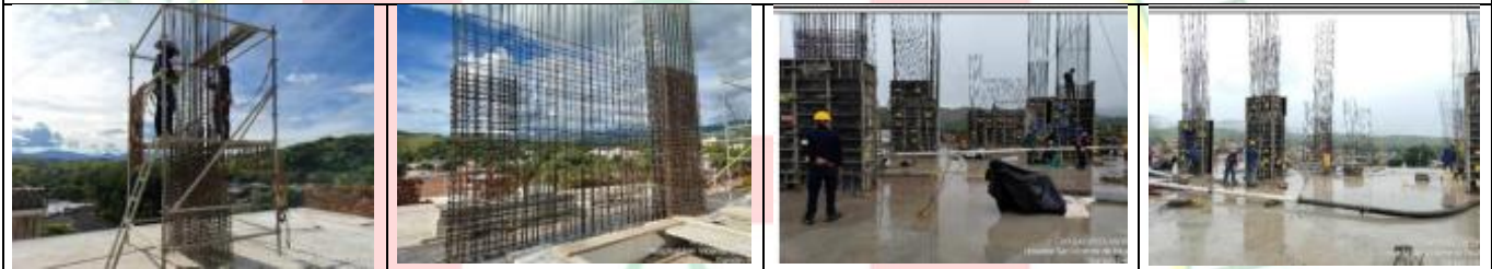
ARMADO DE ACERO DE REFUERZO, ENCOFRADO Y VACIADO DE COLUMNAS TERCER PISO
