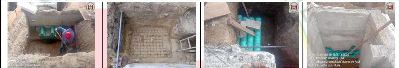
EXCAVACION Y FUNDIDA DE CAJA ELECTRICA PARA SUBESTACION ELECTRICA
