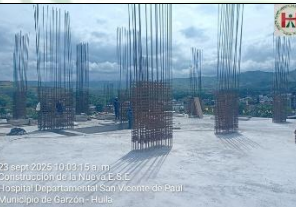
ARMADO DE ACEROS PARA PLACA AÉREA A NIVEL DE SEXTO PISO ENTRE EJES 1-3, ARMADO Y FUNDIDA DE 18 COLUMNAS A NIVEL DE QUINTO PISO ENTRE EJES 5 – 9, ARMADO Y FUNDIDA DE ESCALERA DE EMERGENCIA DE CUARTO A QUINTO PISO SOBRE EJE 9.
