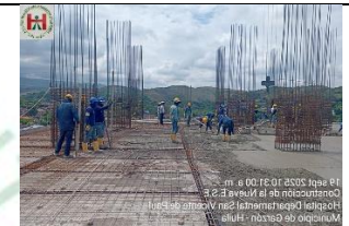
ARMADO DE ACEROS PARA PLACA AÉREA A NIVEL DE SEXTO PISO ENTRE EJES 1-3, ARMADO Y FUNDIDA DE 18 COLUMNAS A NIVEL DE QUINTO PISO ENTRE EJES 5 – 9, ARMADO Y FUNDIDA DE ESCALERA DE EMERGENCIA DE CUARTO A QUINTO PISO SOBRE EJE 9.
