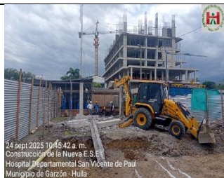
NIVELACIÓN Y ADECUACIÓN DE TERRENO PARA FUNDIDA DE PLACA DE CONTRAPISO EN SUBESTACIÓN DEL EDIFICIO 1 EN LOTE B, DE IGUAL MANERA FUNDIDA DE CÁRCAMOS Y CAJAS ELECTICAS DEL ÁREA DE SUBESTACIÓN, SE REALIZO CERRAMIENTO EN LAMINA EN LOTE B PARA EDIFICIO 3 EN ÁREA DE TANQUE DE RCI, SE REALIZO EXCAVACIÓN MANUAL Y ADECUACIÓN DEL TERRENO PARA TANQUE DE RCI EN LOTE B.
