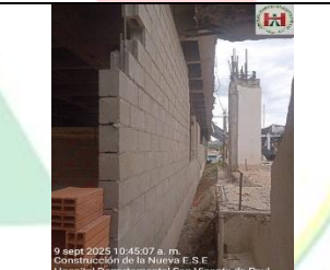
MAMPOSTERÍA EN ZONAS HÚMEDAS ENTRE EJES 2-5 Y E-F, DE IGUAL MANERA MUROS EN BLOQUE DE CONCRETO SOBRE FACHADA DE LA CALLE 6.
