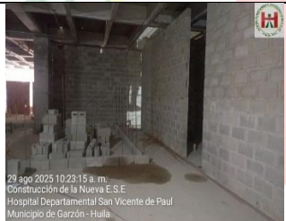
MAMPOSTERÍA EN ARCILLA, DE IGUAL MANERA SE ARMAN Y FUNDEN COLUMNETAS Y VIGAS DE CONFINAMIENTO.
