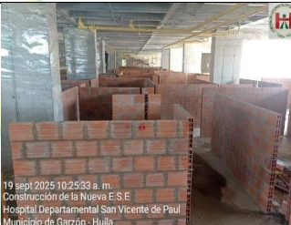
MAMPOSTERÍA EN ZONAS HÚMEDAS ENTRE EJES 2-5 Y E-F, DE IGUAL MANERA MUROS EN BLOQUE DE CONCRETO SOBRE FACHADA DE LA CALLE 6.
