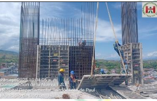
ARMADO DE ACEROS PARA PLACA AÉREA A NIVEL DE SEXTO PISO ENTRE EJES 1-3, ARMADO Y FUNDIDA DE 18 COLUMNAS A NIVEL DE QUINTO PISO ENTRE EJES 5 – 9, ARMADO Y FUNDIDA DE ESCALERA DE EMERGENCIA DE CUARTO A QUINTO PISO SOBRE EJE 9.
