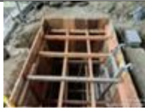
EXCAVACION Y FUNDIDA DE CAJA ELECTRICA PARA SUBESTACION ELECTRICA
