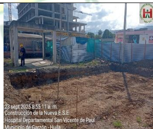
NIVELACIÓN Y ADECUACIÓN DE TERRENO PARA FUNDIDA DE PLACA DE CONTRAPISO EN SUBESTACIÓN DEL EDIFICIO 1 EN LOTE B, DE IGUAL MANERA FUNDIDA DE CÁRCAMOS Y CAJAS ELECTICAS DEL ÁREA DE SUBESTACIÓN, SE REALIZO CERRAMIENTO EN LAMINA EN LOTE B PARA EDIFICIO 3 EN ÁREA DE TANQUE DE RCI, SE REALIZO EXCAVACIÓN MANUAL Y ADECUACIÓN DEL TERRENO PARA TANQUE DE RCI EN LOTE B.
