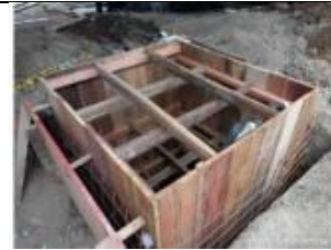
EXCAVACION Y FUNDIDA DE CAJA ELECTRICA PARA SUBESTACION ELECTRICA
