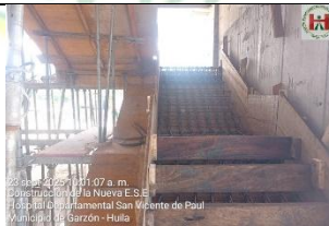
ARMADO DE ACEROS PARA PLACA AÉREA A NIVEL DE SEXTO PISO ENTRE EJES 1-3, ARMADO Y FUNDIDA DE 18 COLUMNAS A NIVEL DE QUINTO PISO ENTRE EJES 5 – 9, ARMADO Y FUNDIDA DE ESCALERA DE EMERGENCIA DE CUARTO A QUINTO PISO SOBRE EJE 9.
