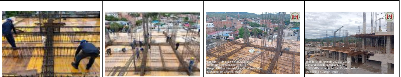
ARMADO DE ESTRUCTURA DE SOPORTE, ACEROS DE REFUERZO DE VIGAS Y VIGUETAS, INSTALACION DE CASETONES Y FUNDIDA DE PLACA 2 PISO DE LOS EJES 7-11 AL A-F
