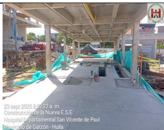
NIVELACIÓN Y ADECUACIÓN DE TERRENO PARA FUNDIDA DE PLACA DE CONTRAPISO EN SUBESTACIÓN DEL EDIFICIO 1 EN LOTE B, DE IGUAL MANERA FUNDIDA DE CÁRCAMOS Y CAJAS ELECTICAS DEL ÁREA DE SUBESTACIÓN, SE REALIZO CERRAMIENTO EN LAMINA EN LOTE B PARA EDIFICIO 3 EN ÁREA DE TANQUE DE RCI, SE REALIZO EXCAVACIÓN MANUAL Y ADECUACIÓN DEL TERRENO PARA TANQUE DE RCI EN LOTE B.
