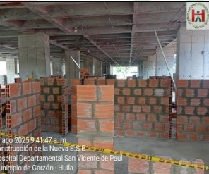
MAMPOSTERÍA EN ARCILLA, DE IGUAL MANERA SE ARMAN Y FUNDEN COLUMNETAS Y VIGAS DE CONFINAMIENTO.
