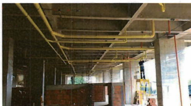
Ilustración 12. Descuelgue y tendido de red sanitaria bajo placa piso 2.
