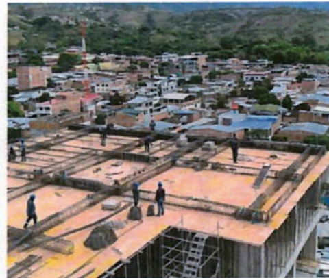
Ilustración 17. Armado de aceros
