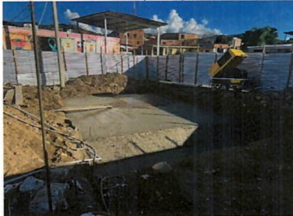
Ilustración 2. Excavaciones para implantación tanque RCI
