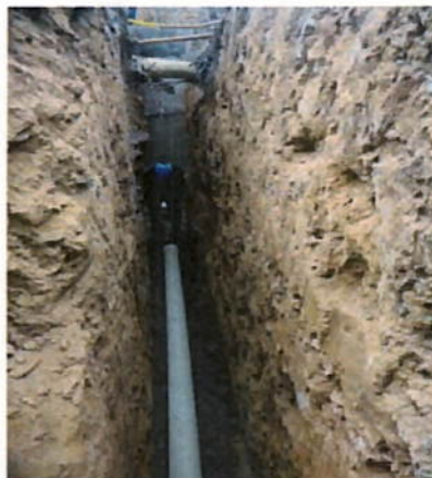
Ilustración 13. Descuelgue y tendido de red sanitaria bajo placa piso 3.
