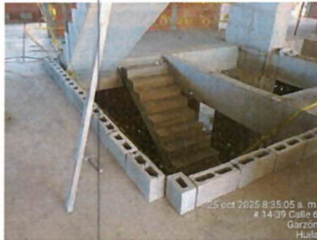
Ilustración 7. Zimbra forme y liberación para armado de mampostería
