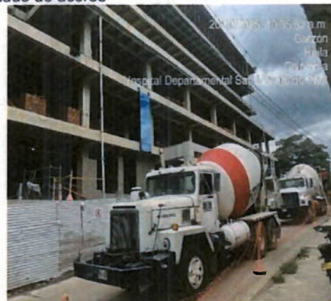
Ilustración 18. Vaciado de concreto en placa
