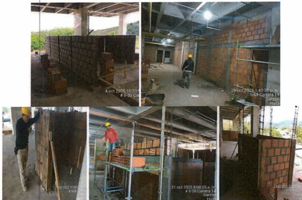
Ilustración 5. Armado de mampostería
