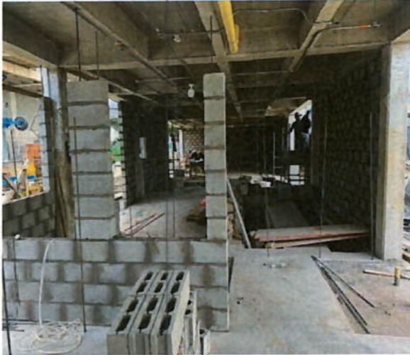
Ilustración 4. Mampostería para subestación eléctrica
