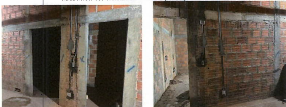
Ilustración 11. Instalación de ductería EMT en muros
