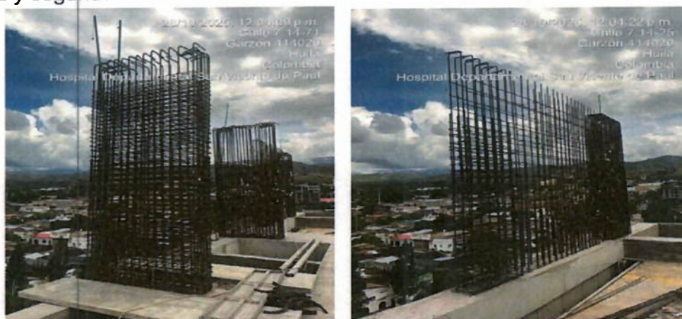
Ilustración 15. Armado aceros columnas y muro cortina.
