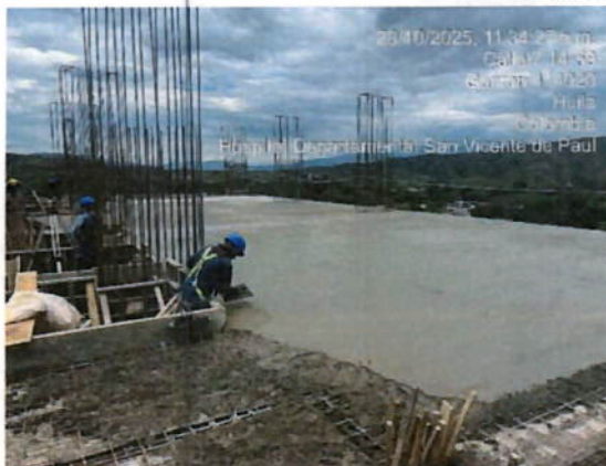
Ilustración 18. Vaciado de concreto en placa
