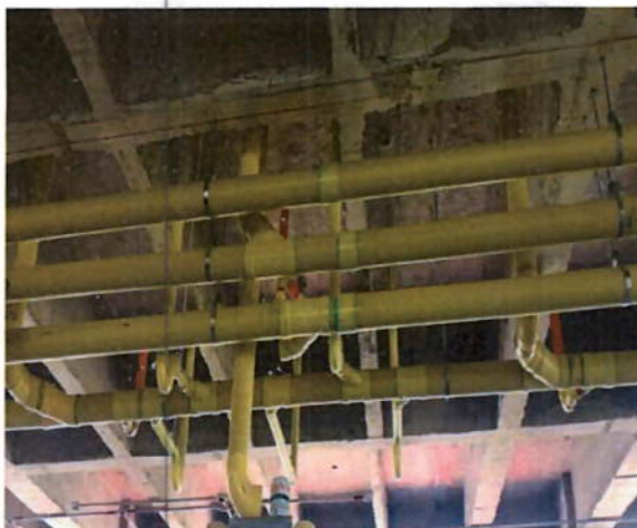
Ilustración 13. Descuelgue y tendido de red sanitaria bajo placa piso 3.
