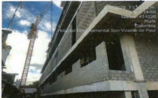
Ilustración 7. Zimbra forme y liberación para armado de mampostería
