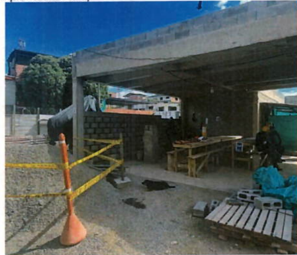
Ilustración 4. Mampostería para subestación eléctrica
