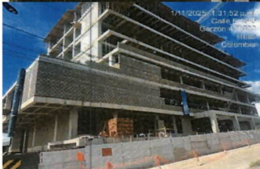
Ilustración 8. Armado de mampostería fachada
