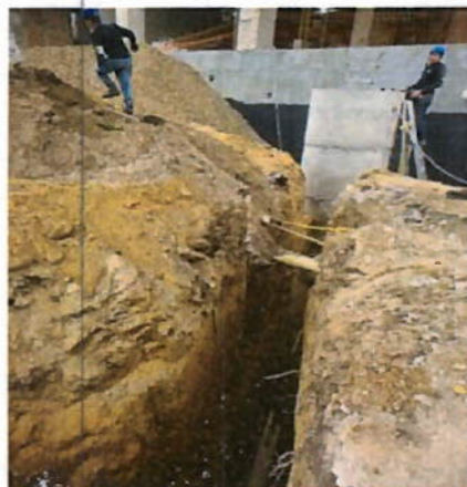
Ilustración 13. Descuelgue y tendido de red sanitaria bajo placa piso 3.
