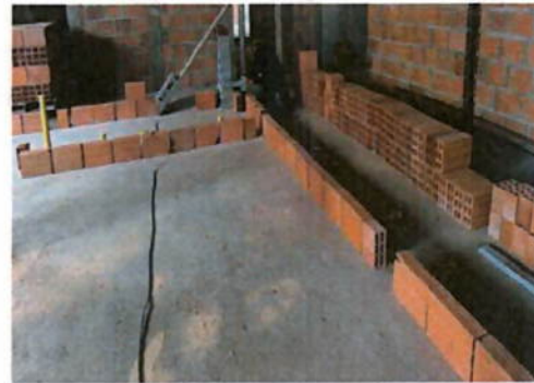
Ilustración 7. Zimbra forme y liberación para armado de mampostería
