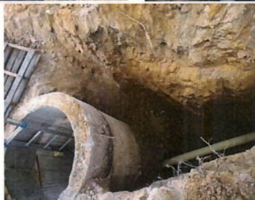
Ilustración 14. Conexión a red principal de alcantarillado municipal.
