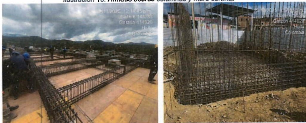
Ilustración 16. Armado de aceros
