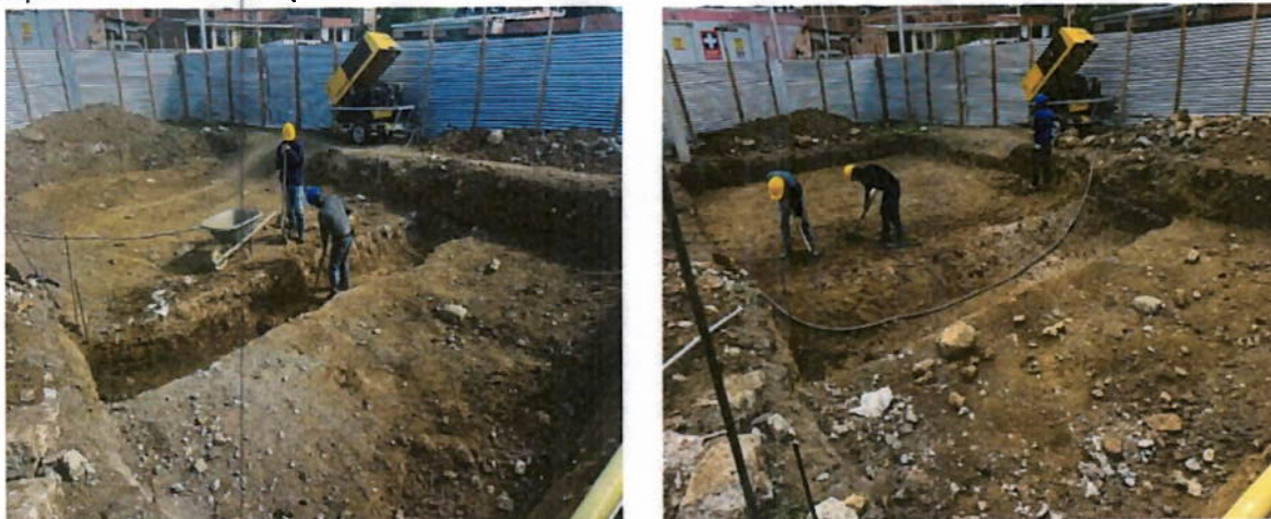
Ilustración 2. Excavaciones para implantación tanque RCI
