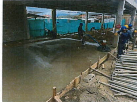
Ilustración 3 vaciado de concreto placa de contra piso
