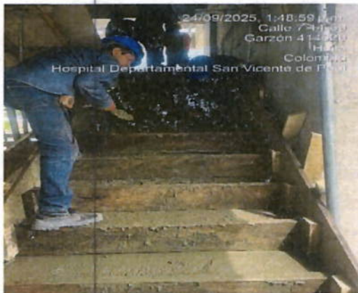
Ilustración 24 concreto escaleras.
