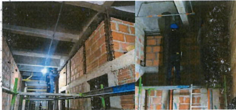
Ilustración 6 Elementos de confinamiento
