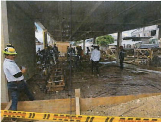
Ilustración 2 conformación de cárcamos e instalación de malla electro soldada
