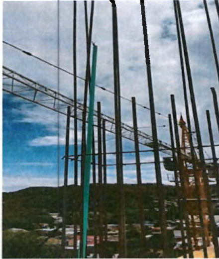
Ilustración 18 ductos verticales para bajantes de apantallamiento y tendido de ducteria emt
