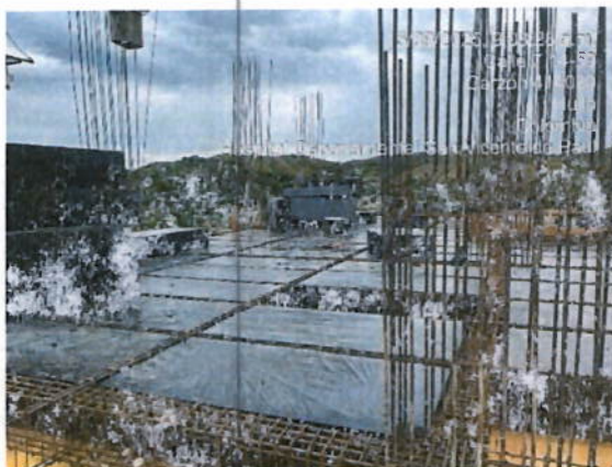
Ilustración 25 Instalación de malla y casetón.
