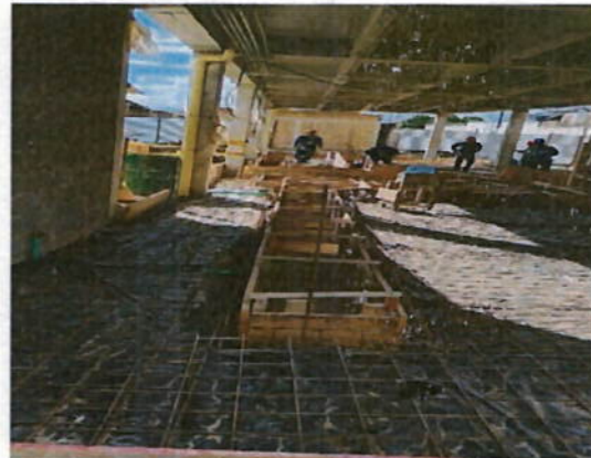
Ilustración 2 conformación de cárcamos e instalación de malla electro soldada
