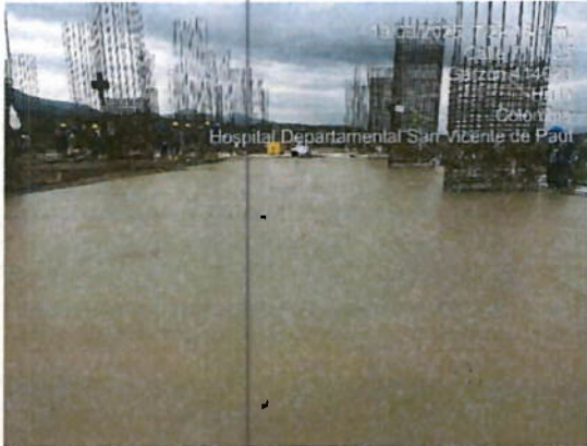
Ilustración 23 Vaciado de concreto en placa
