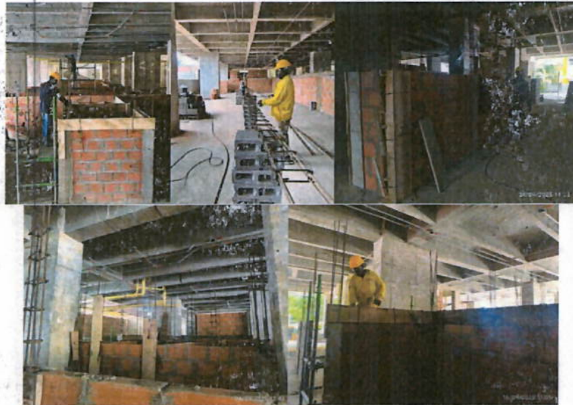
Ilustración 10 Elementos de confinamiento
