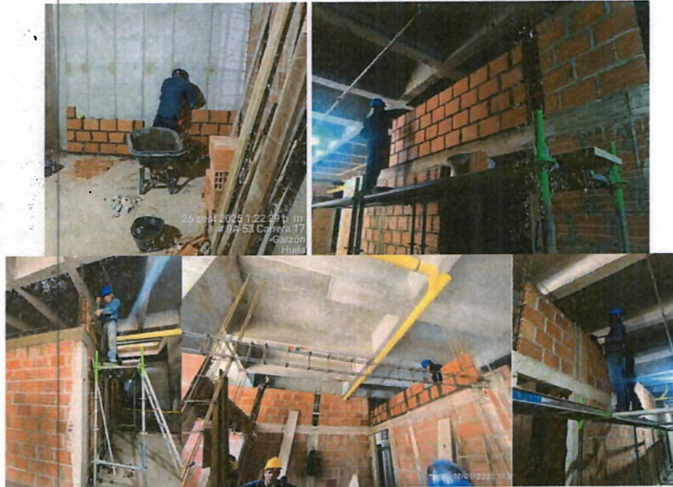
Ilustración 5 Armado de mampostería
