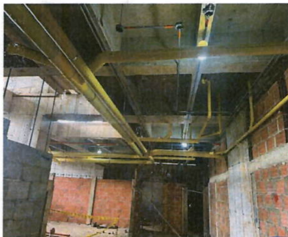
Ilustración 19 Descuelgue y tendido de red sanitaria bajo placa piso 2 y sótano
