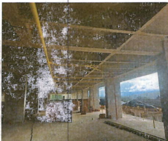
Ilustración 19 Descuelgue y tendido de red sanitaria bajo placa piso 2 y sótano
