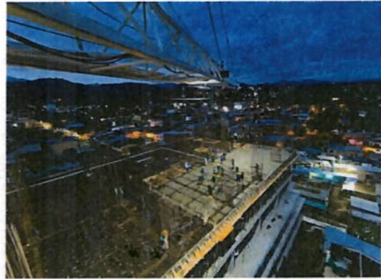
Ilustración 23 Vaciado de concreto en placa
