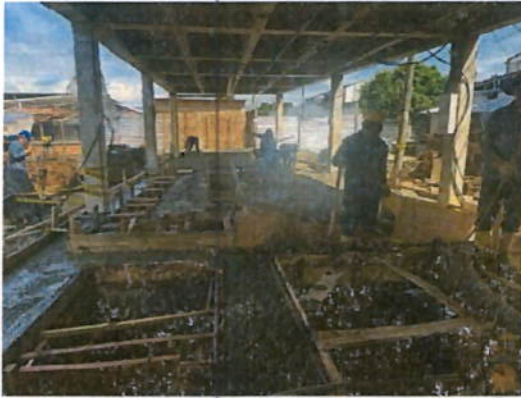
Ilustración 3 vaciado de concreto placa de contra piso
