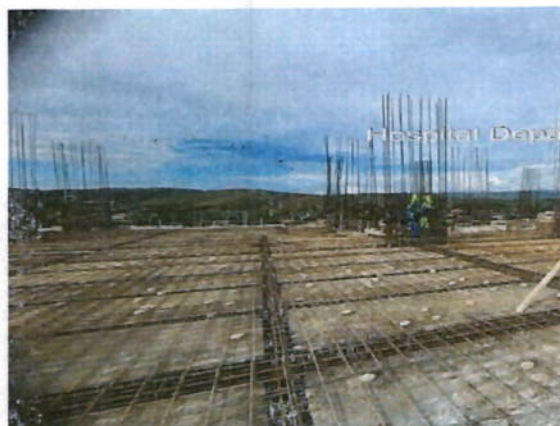
Ilustración 25 Instalación de malla y casetón.
