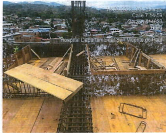
Ilustración 21 Armado de aceros
