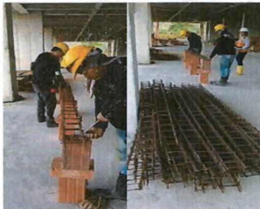
Ilustración 16 Armado de acero para elementos no estructurales
