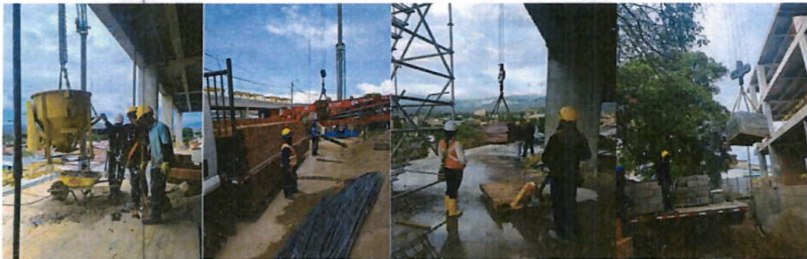
Ilustración 15 Trasiego de material a piso 3 y 4
