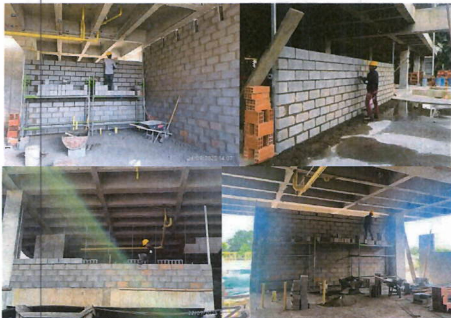
Ilustración 9 Armado de mampostería de fachada
