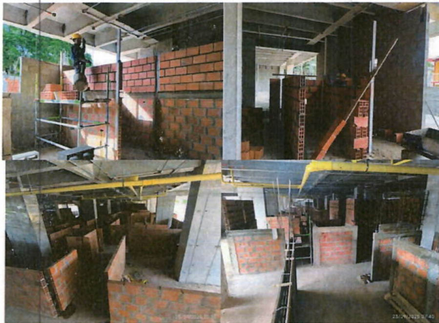
Ilustración 8 Armado de mampostería interior
