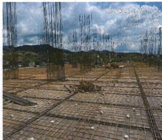
Ilustración 22 Armado de áceros
