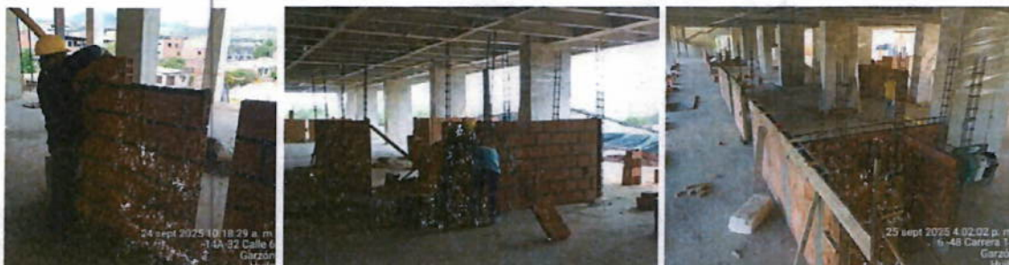
Ilustración 12 Armado de mampostería
