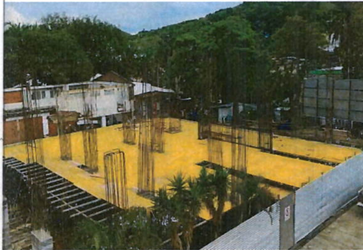
Ilustración 34 sistema de encofrado STEM
