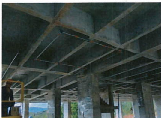
Ilustración 12 Demarcación con código de colores de ductería sistemas
