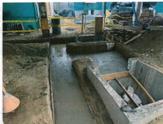
Ilustración 3 Conformación de cajas internas y cárcamos de conexión
