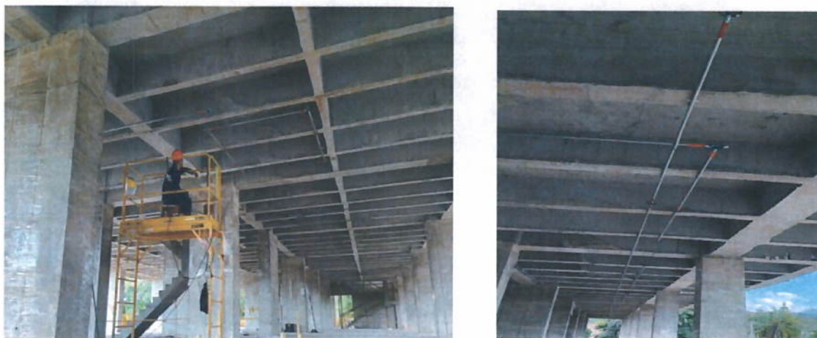
Ilustración 11 Instalación ducteria
