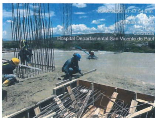
Ilustración 18 Vaciado de concreto en placa
