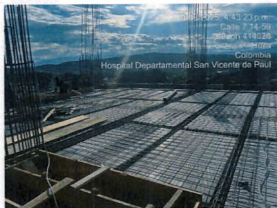
Ilustración 20 Instalación de malla y casetón.
