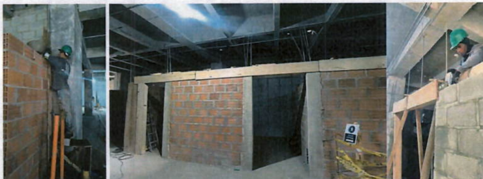
Ilustración 6 Elementos de confinamiento
