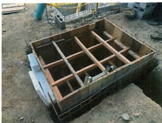
Ilustración 3 Conformación de cajas internas y cárcamos de conexión
