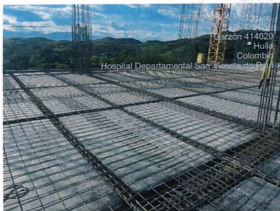
Ilustración 20 Instalación de malla y casetón.
