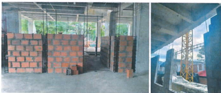
Ilustración 10 Elementos de confinamiento
