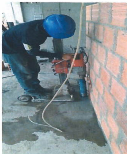
Ilustración 13 Perforación con saca núcleos
