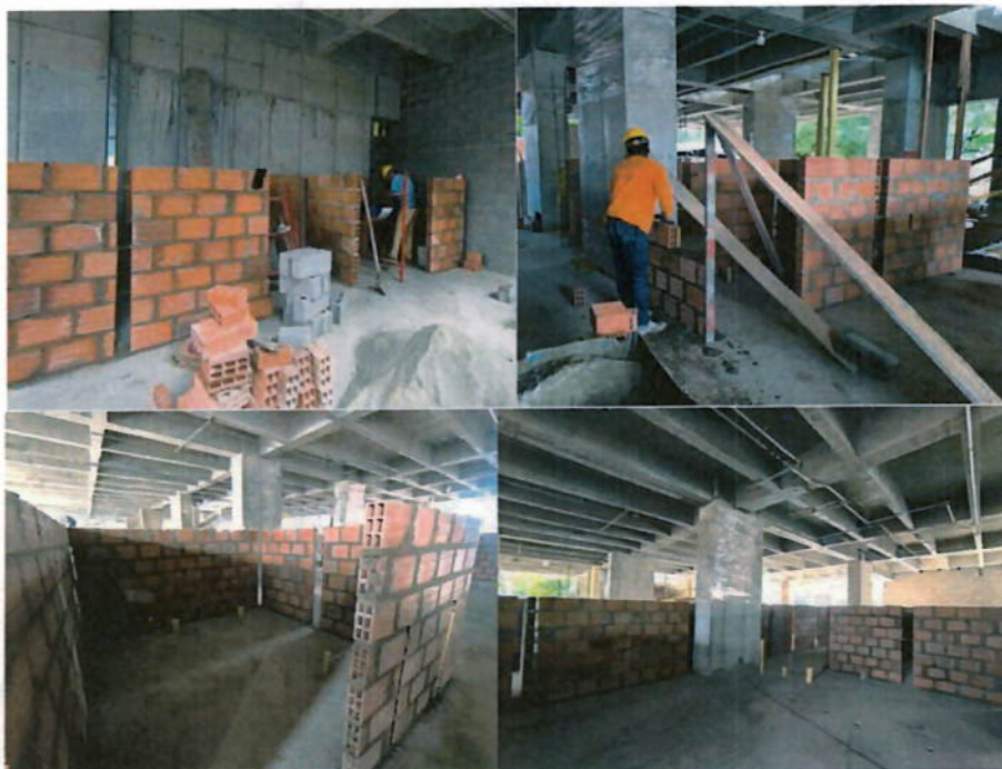
Ilustración 9 Armado de mampostería
