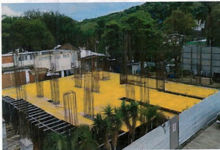
Ilustración 30 sistema de encofrado STEM
