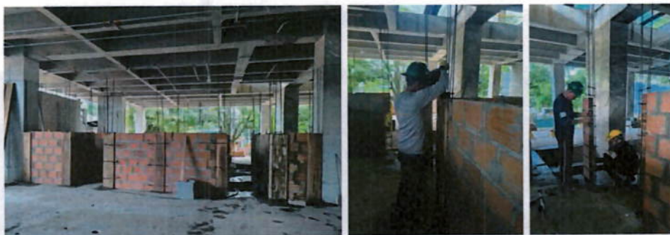
Ilustración 9 Armado de mampostería
