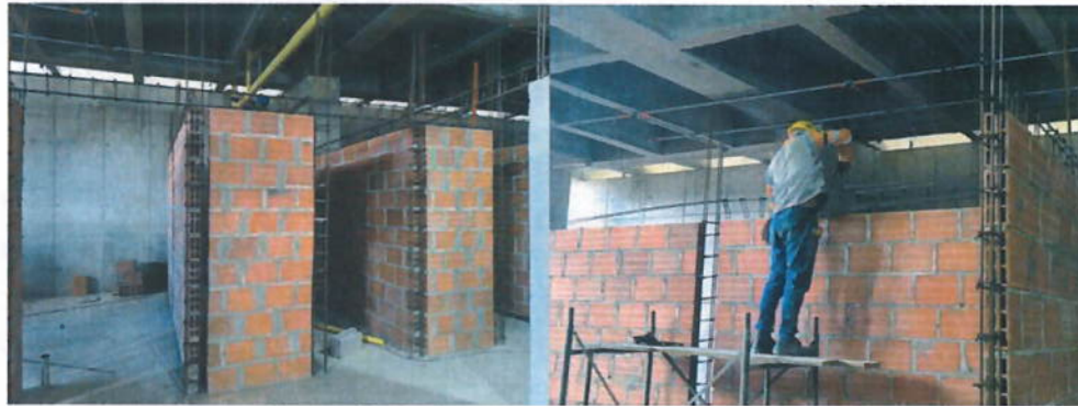
Ilustración 7 Elementos de confinamiento
