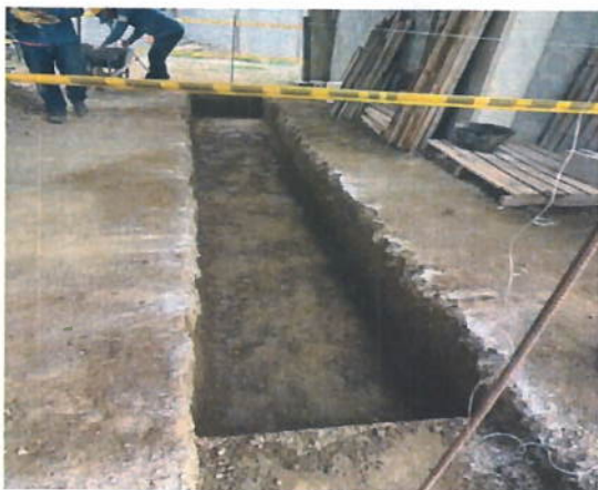
Ilustración 2 Excavaciones ora cárcamos de conexión interna
