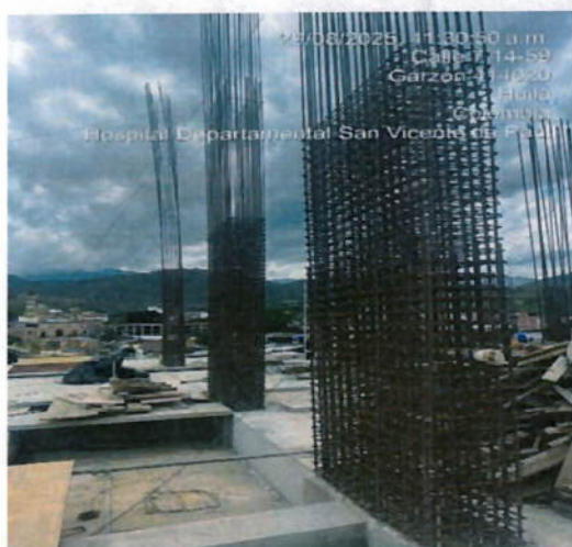
Ilustración 15 Armado aceros columnas y muro cortina.
