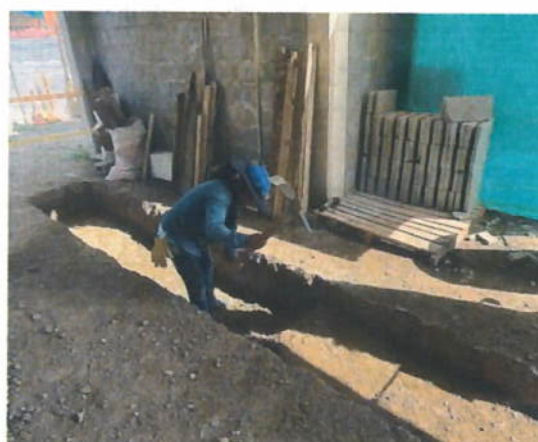
Ilustración 2 Excavaciones ora cárcamos de conexión interna
