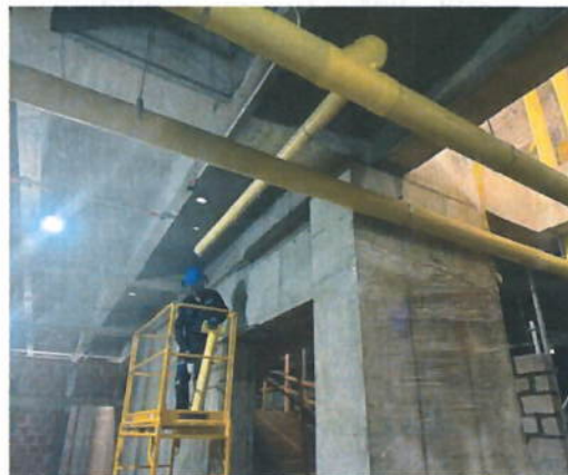
Ilustración 14 Descuelgue y tendido de red sanitaria bajo placa piso 1
