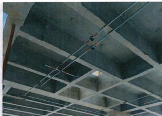
Ilustración 12 Demarcación con código de colores de ductería sistemas
