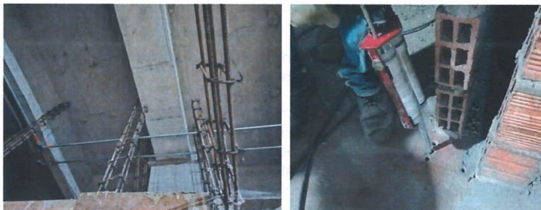
Ilustración 4 Anclaje de dovelas y elementos no estructurales
