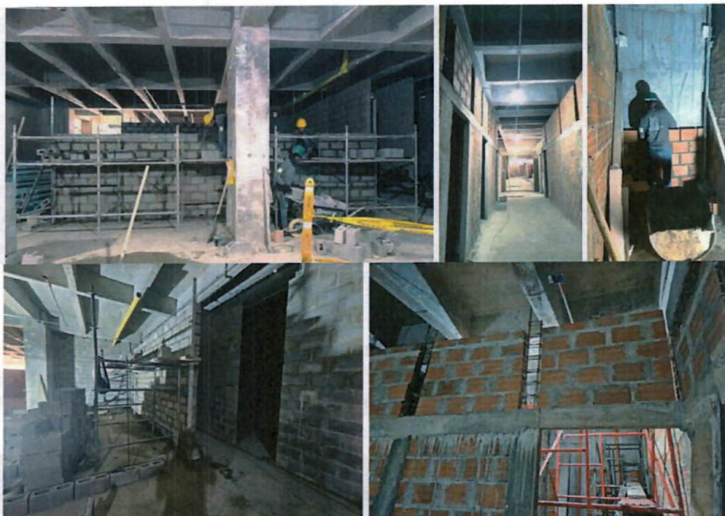
Ilustración 5 Armado de mampostería
