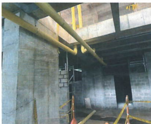
Ilustración 14 Descuelgue y tendido de red sanitaria bajo placa piso 1
