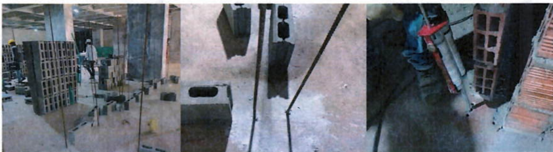
Ilustración 3 Anclaje de dovelas y elementos no estructurales
