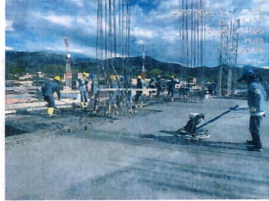
Ilustración 13 Vaciado de concreto en placa
