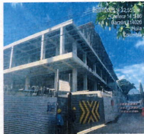
Ilustración 17 Encofrado y fundida de columnas
