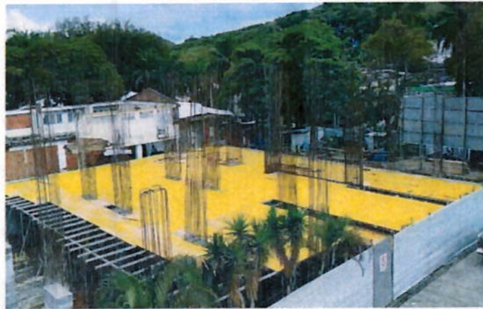
Ilustración 22 sistema de encofrado STEM
