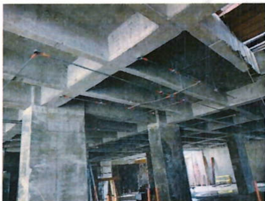
Ilustración 9 Demarcación con código de colores de ducteria sistemas
