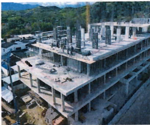
Ilustración 17 Encofrado y fundida de columnas
