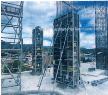
Ilustración 17 Encofrado y fundida de columnas
