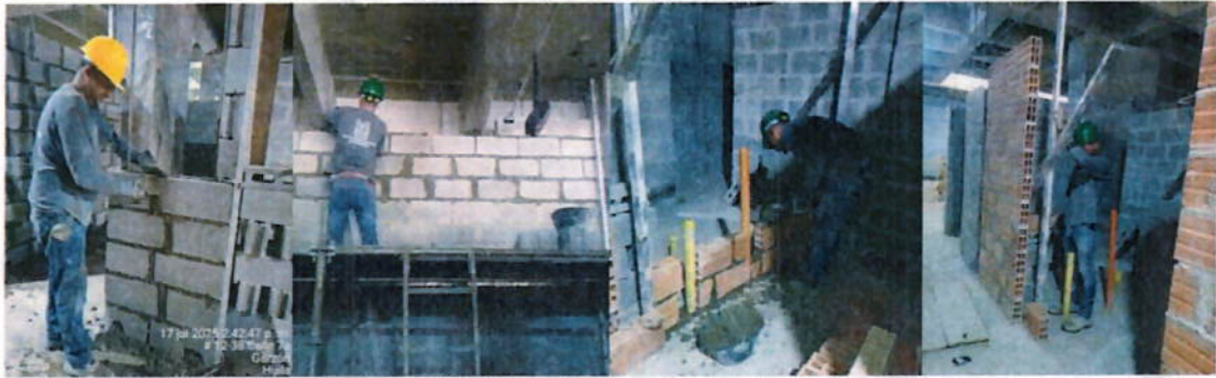
Ilustración 4 Armado de mampostería
