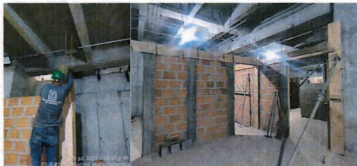
Ilustración 6 elementos de confinamiento
