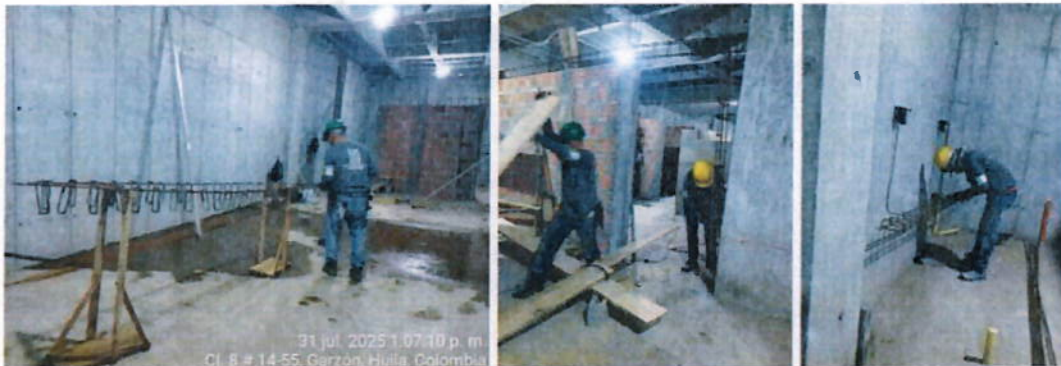
Ilustración 5 Amarre de elementos de confinamiento
