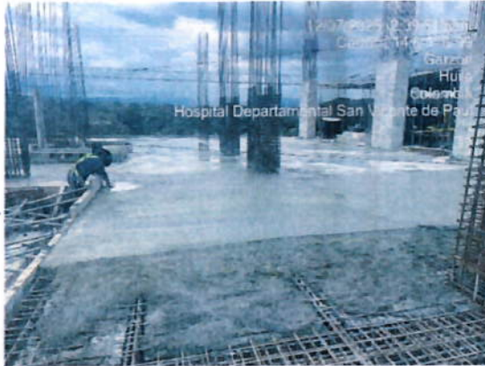
Ilustración 13 Vaciado de concreto en placa
