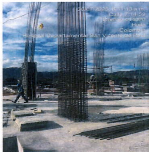
Ilustración 10 Armado aceros columnas y muro cortina.
