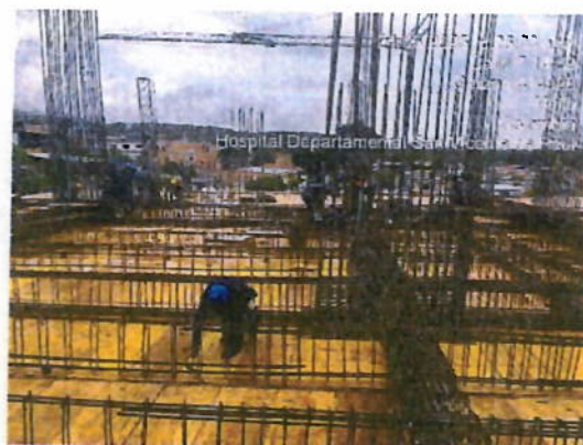
Ilustración 5 armado de aceros
