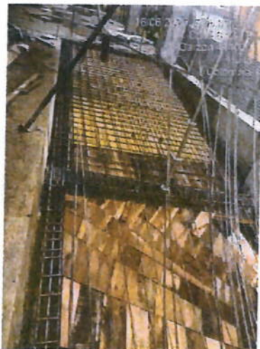
Ilustración 4 Armado aceros rampa salida ambulancias
