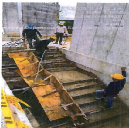
Ilustración 10 Encofrado y fundidas escaleras
