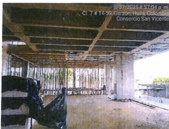
Ilustración 8 Desmonte casetón
