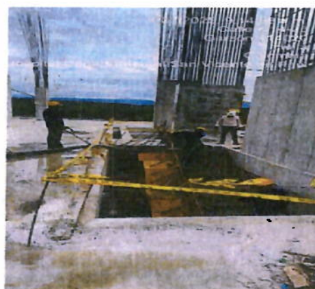
Ilustración 10 Encofrado y fundidas escaleras
