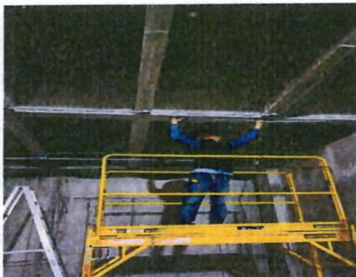
Ilustración 3 Demarcación con código de colores de ducteria sistemas
