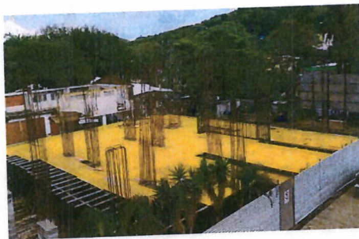
Ilustración 16 sistema de encofrado STEM
