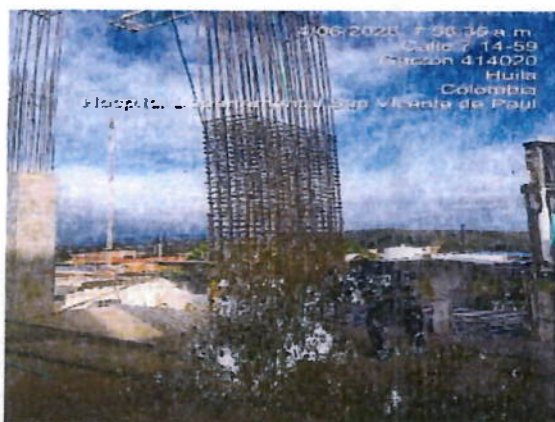
Ilustración 9 Armado de aceros en columnas piso 1
