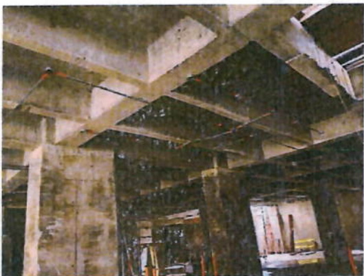
Ilustración 3 Demarcación con código de colores de ducteria sistemas
