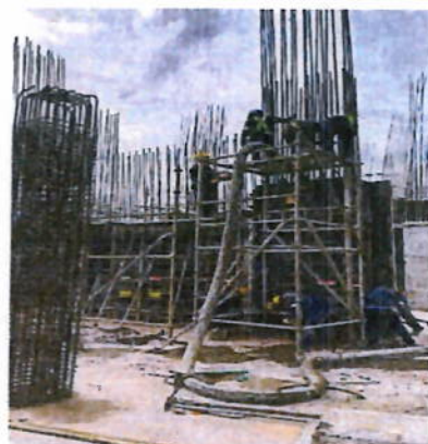
Ilustración 11 Encofrado y fundida de columnas
