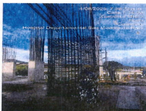
Ilustración 9 Armado de aceros en columnas piso 1
