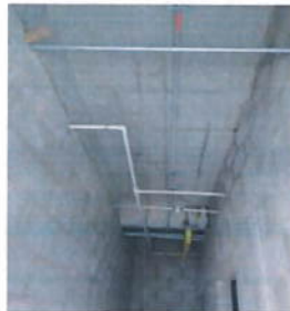
ARMADO DE DUCTOS PARA CAJAS ELECTRICAS EN SUB ESTACION E INSTALACION DE DUCTERIA DE ILUMINACION EDIFICIO ASISTENCIAL PLACA DESOTANO Y LOTE B
