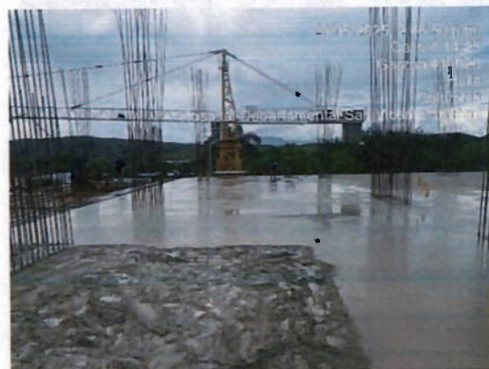
Ilustración 8 Vaciado de concreto placa entrepiso
