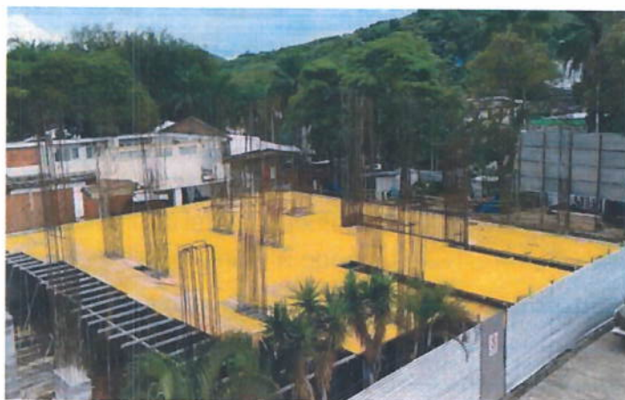
Ilustración 17 sistema de encofrado STEM
