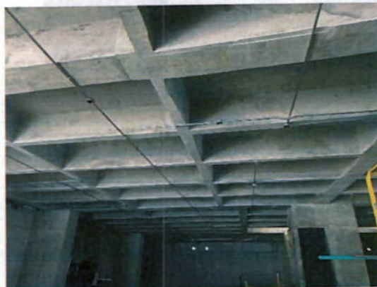
Ilustración 3 Tendido de ducteria sistema de iluminación
