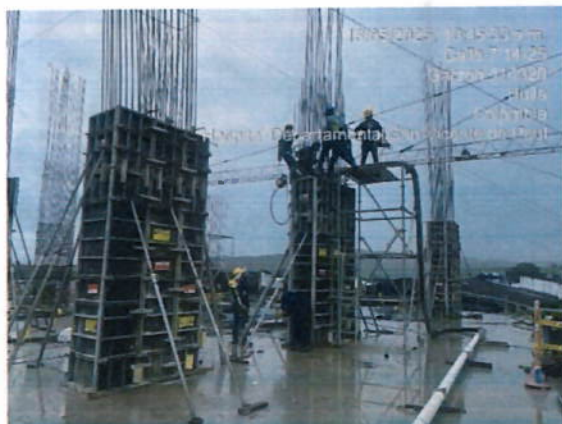
Ilustración 7 Vaciado de concreto pantallas y columnas
