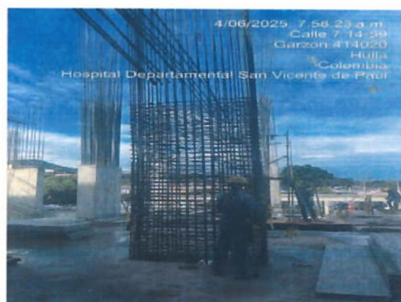
Ilustración 10 Armado de aceros en columnas piso 1
