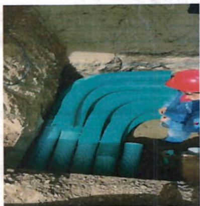
Ilustración 2 instalación tuberías eléctricas subterráneas
