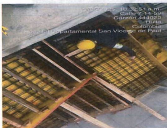
Ilustración 12 Armado de acero escaleras
