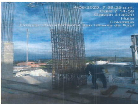
Ilustración 10 Armado de aceros en columnas piso 1
