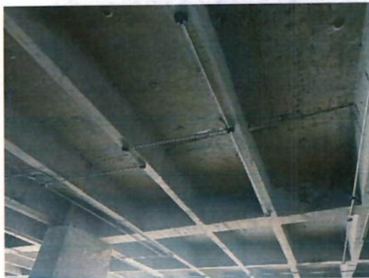
Ilustración 3 Tendido de ducteria sistema de iluminación
