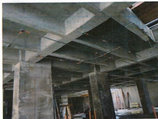
Ilustración 4 Demarcación con código de colores de ducteria sistemas
