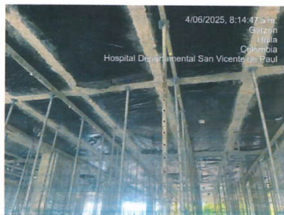
Ilustración 9 Desmonte casetón
