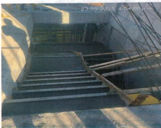
Ilustración 11 Encofrado y fundidas escaleras
