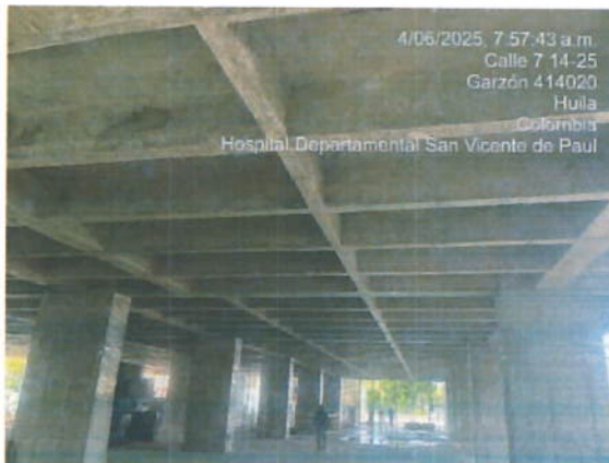
Ilustración 9 Desmonte casetón
