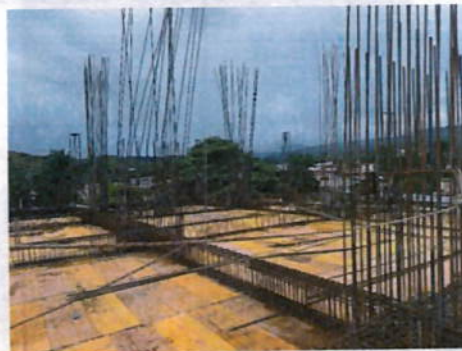
ARMADO DE ACERO DE REFUERZO PARA VIGAS DE ENTRE PISO ENTRE EJES AF Y EJES 1 a 4 SOBRE NIVEL
