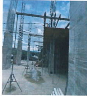
ARMADO DE CAMA Y FORMALETA PARA PLACA DE ENTRE PISO NIVEL 3
