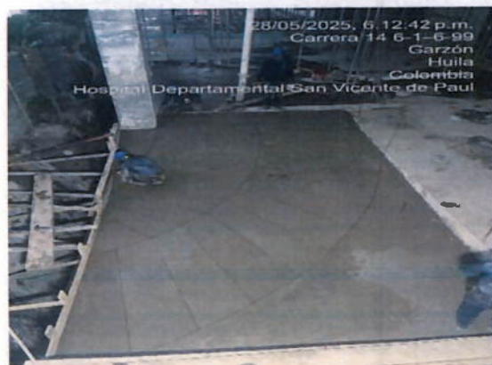
Ilustración 8 Vaciado de concreto placa entrepiso
