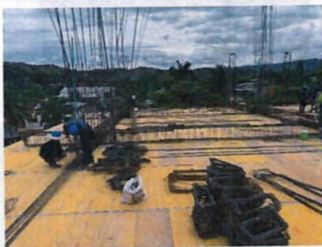
ARMADO DE ACERO DE REFUERZO PARA VIGAS DE ENTRE PISO ENTRE EJES AF Y EJES 1 a 4 SOBRE NIVEL
