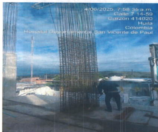
Ilustración 6 Amarre de aceros e instalación de casetón
