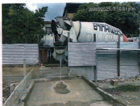
Ilustración 25 Lavado de mixer
