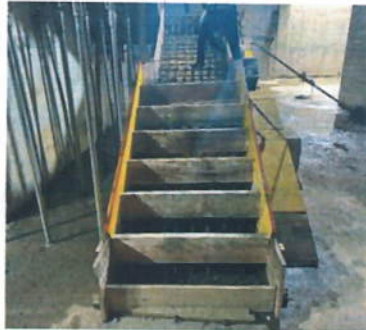
ARMADO, AMARRE DE ACERO Y VACIADO DE CONCRETO ESCALERAS DE EMERGENCIA
