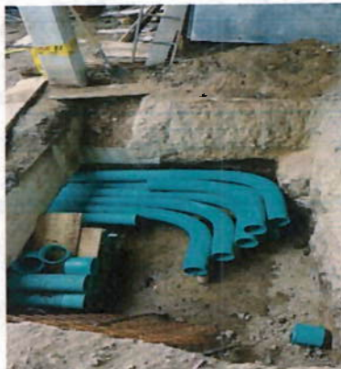
Ilustración 2 instalación tuberías eléctricas subterráneas
