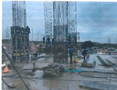
ARMADO, AMARRE DE ACERO Y VACIADO DE CONCRETO ESCALERAS DE EMERGENCIA
