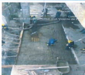
VACIADO DE CONCRETO RAMPA DE ACCESO URGENCIAS ENTRE EJES 3-4
