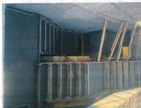
Ilustración 11 Encofrado y fundidas escaleras
