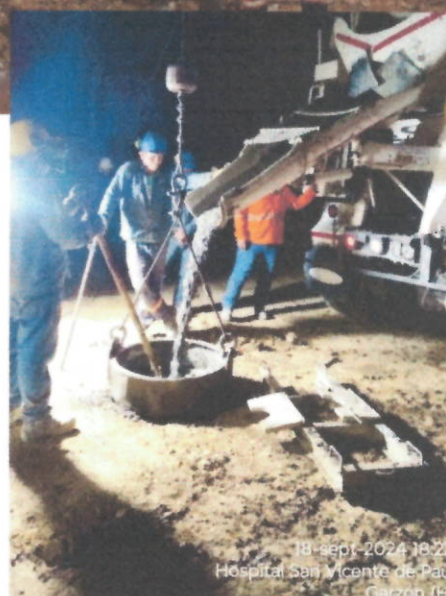
Suministro de concreto Tremí premezclado 4.000 PSI, concretera "HORMIHUILA"
