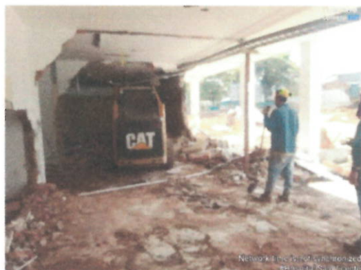
Demolición muros interiores y desmonte de cubierta
