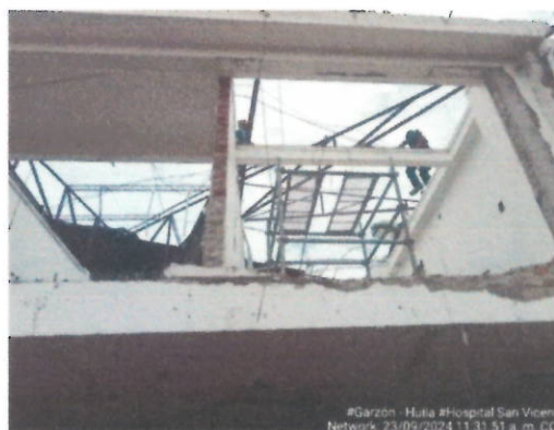
Demolición muros interiores y desmonte de cubierta
