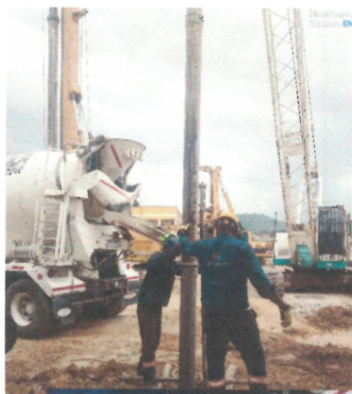
Proceso de instalación acero de refuerzo y tubería para concreto tipo Tremi, previo a la fundida.
