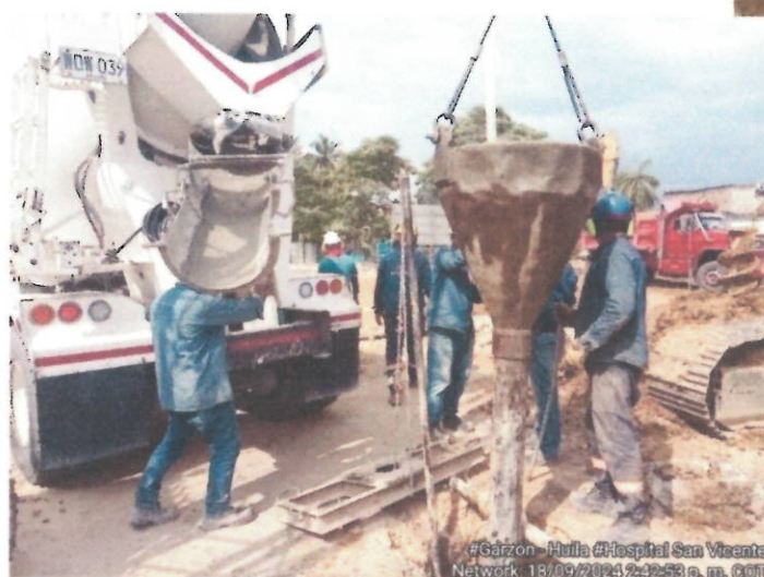
Proceso de instalación acero de refuerzo y tubería para concreto tipo Tremi, previo a la fundida.
