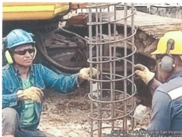
Proceso de instalación acero de refuerzo y tubería para concreto tipo Tremi, previo a la fundida.
