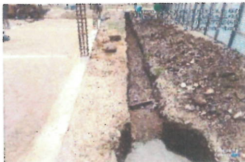
Proceso de excavación para cajas de inspección y redes sanitarias lote B
