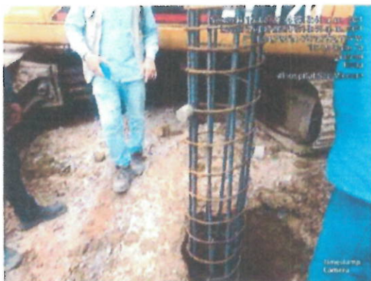
Proceso de perforación y fundida de pilotes.
