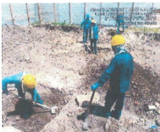
La actividad incluye la excavación para zapatas y base en concreto ciclópeo.
