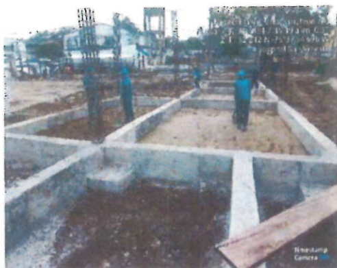
Vigas de cimentación edificio 2 lote B
