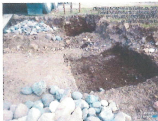
La actividad incluye la excavación para zapatas y base en concreto ciclópeo.
