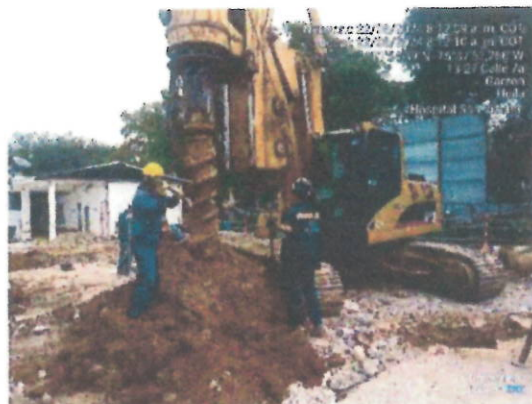
Proceso de perforación y fundida de pilotes.
