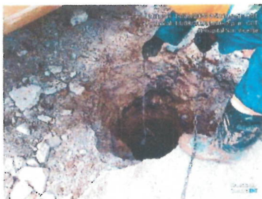
Proceso de perforación y fundida de pilotes.
