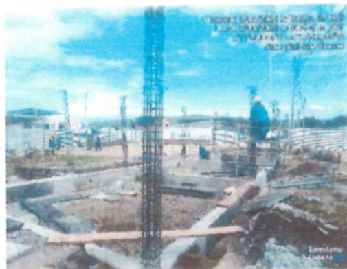
Vigas de cimentación edificio 1 lote B
