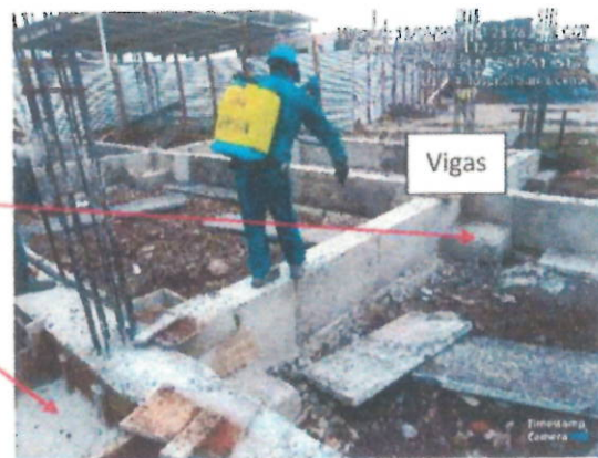
Imágenes armado y fundida de zapatas en edificio 2
