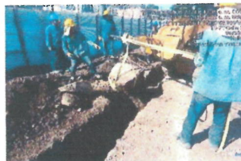
Proceso de excavación para cajas de inspección y redes sanitarias lote B
