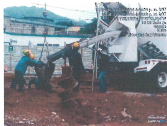
Proceso de perforación y fundida de pilotes.
