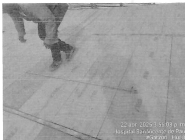
Replanteo y cimbrado manual para vigas de refuerzo de placas
