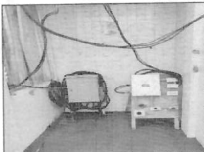
Foto 23. Tableros electricos protegidos para el invierno.
