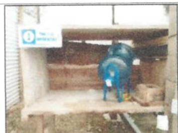
Foto 19. Inspección de puntos de hidratación
