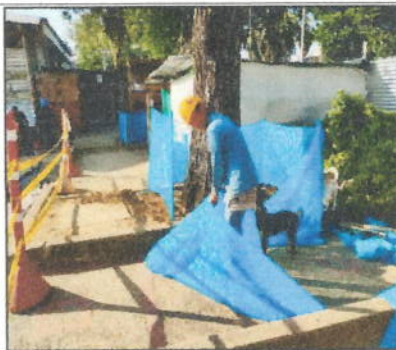
Foto 11. Mantenimiento de cerramientos
