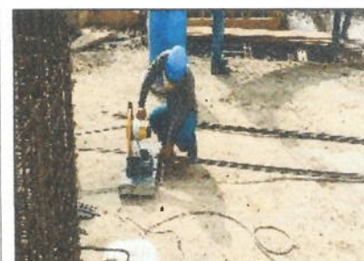
Foto 12. Inspección de trozadora.
