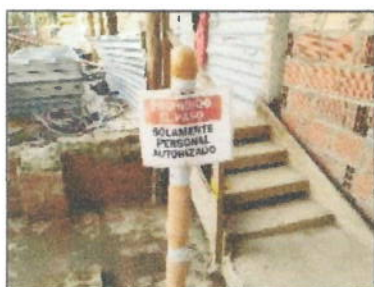
Foto 31. Señalización de obra
