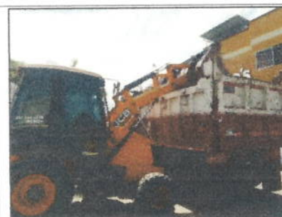
Foto 7. Cargue de volquetas.
