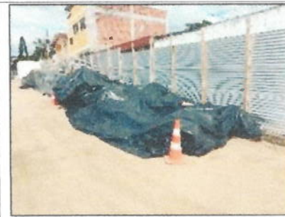
Foto 6. Protección al acero.
