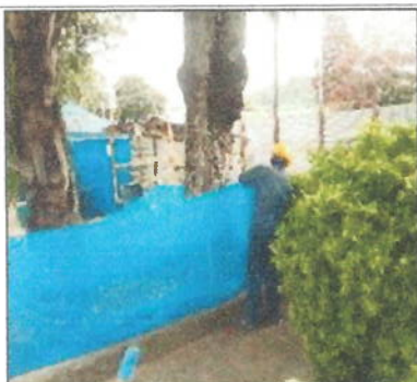
Foto 10. Mantenimiento de cerramientos
