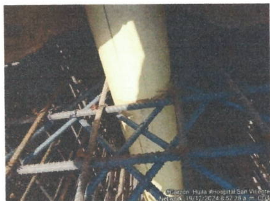
Refuerzo de tubería en pase sobre vigas
