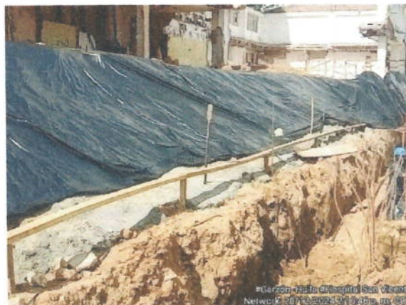
Talud de protección de excavación Eje F costado occidental del lote A
