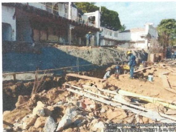
Talud de protección de excavación Eje F costado occidental del lote A
