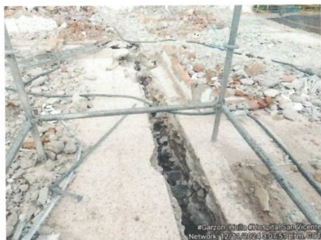
Corte de placa para debilitar estructura
