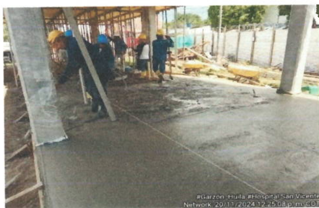
Proceso de fundida y nivelación de placa de contrapiso.
