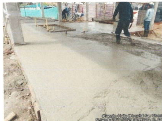
Proceso de fundida y nivelación de placa de contrapiso.
